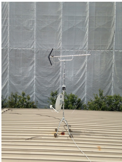
品川区西大井 セキスイハイム様物件 地デジアンテナとBSアンテナ屋根上工事
