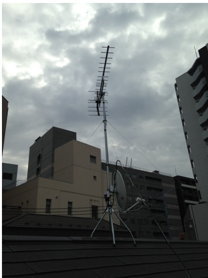
品川区平塚 住友林業様物件 地デジアンテナとBSアンテナ屋根上工事
