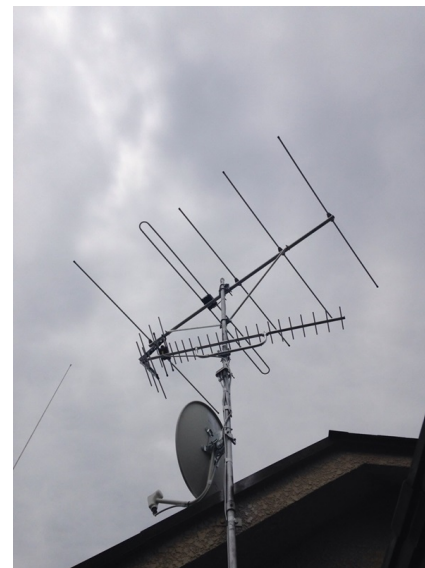
品川区小山台 ダイケンホーム様物件 地デジアンテナとBSアンテナ追加工事
