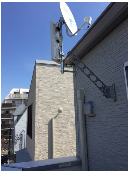
品川区小山台 オープンハウス様物件 壁面取付 デザインアンテナとBSアンテナ工事
