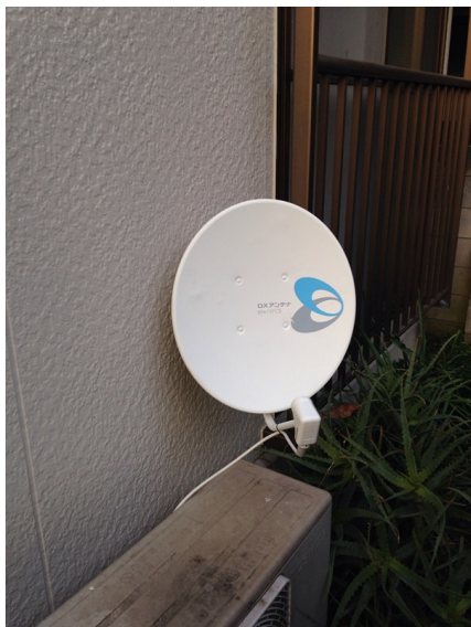
世田谷区世田谷 ベランダ取付 BSアンテナ工事
