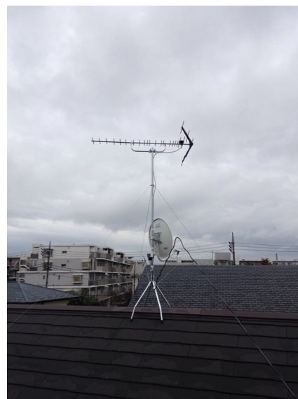
世田谷区上祖師谷 地デジアンテナとBSアンテナ屋根上工事
