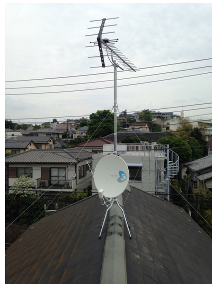
世田谷区尾山台 地デジアンテナとBSアンテナ屋根上工事
