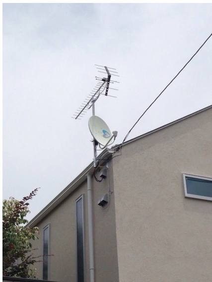
世田谷区岡本 壁面取付 地デジアンテナとBSアンテナ工事
