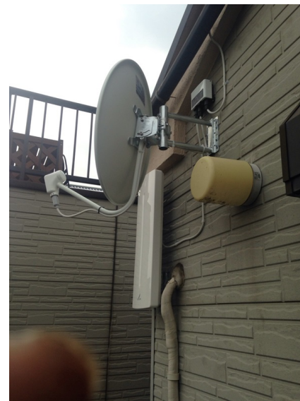
世田谷区八幡山 壁面取付 デザインアンテナとBSアンテナ工事
