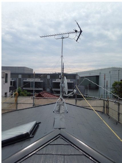
世田谷区給田 地デジアンテナとBSアンテナ屋根上工事
