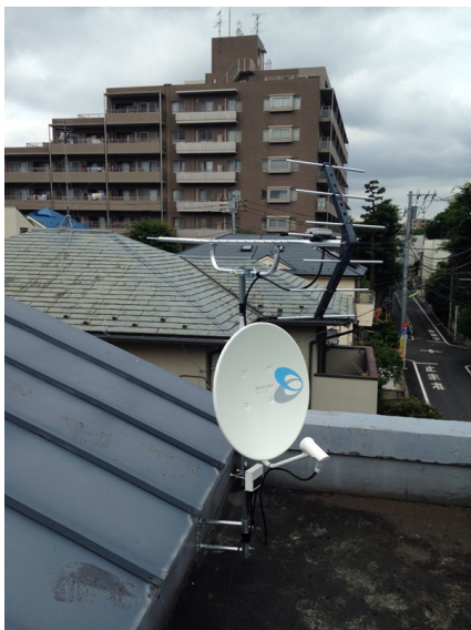
世田谷区深澤 壁面取付 地デジアンテナとBSアンテナ工事
