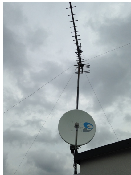
世田谷区若林 壁面取付 地デジアンテナとBSアンテナ工事
