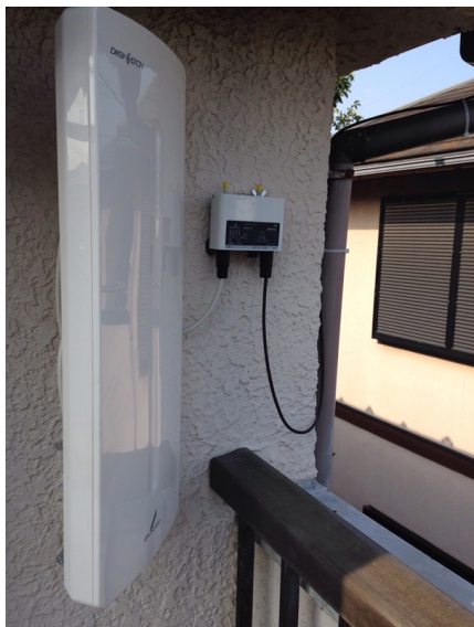
世田谷区祖師谷 壁面取付 デザインアンテナ工 事
