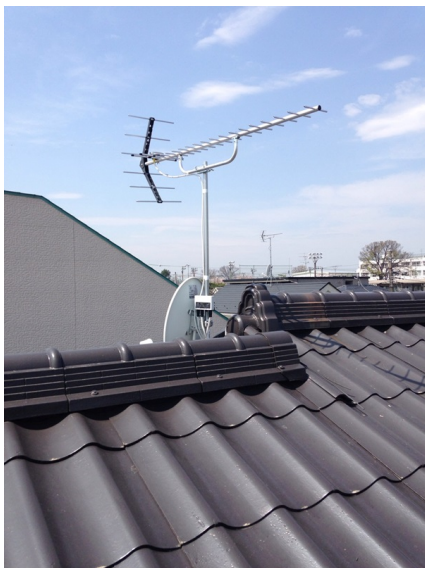
世田谷区桜上水 壁面取付 地デジアンテナとBSアンテナ工事
