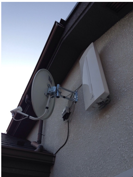
世田谷区代沢 壁面取付 デザインアンテナとBSアンテナ工事
