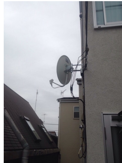
世田谷区八幡山 壁面取付 BSアンテナ工事
