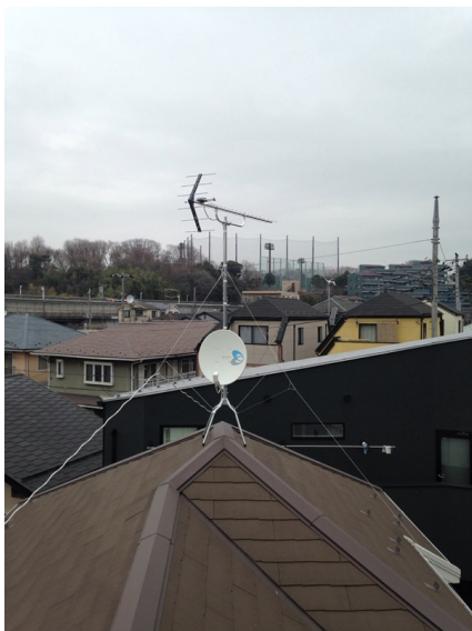
世田谷区大蔵 地デジアンテナとBSアンテナ屋根上工事
