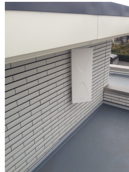
世田谷区喜多見 一条工務店様ご物件 壁面取付 デザインアンテナ工事
