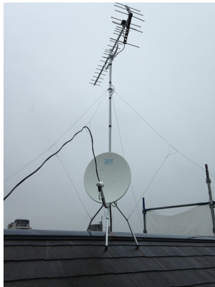
世田谷区奥沢 花まるリフォーム様ご物件 屋根上設置 八木式アンテナとBS/CSアンテナ工事
