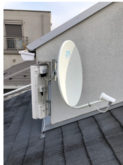
世田谷区松原 東急住宅リース様ご物件 壁面取付 デザインアンテナとBS/CSアンテナ工事
