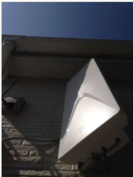
世田谷区上北沢 東急住宅リース様ご物件 壁面取付 デザインアンテナ工事
