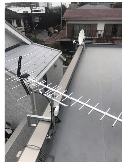
世田谷区上用賀 パナホーム様ご物件 八木式アンテナとBS/CSアンテナ工事
