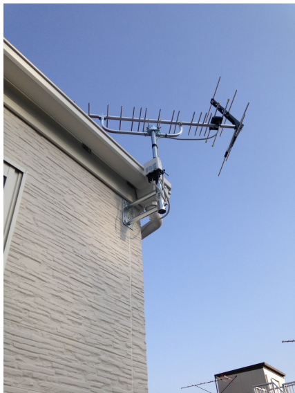
世田谷区経堂 レジデンシャル不動産様ご物件 壁面取付 八木式アンテナ工事
