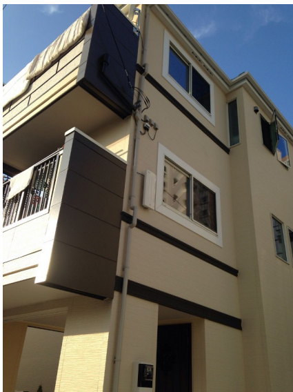
江東区東砂 壁面取付 デザインアンテナ工事後の外観
