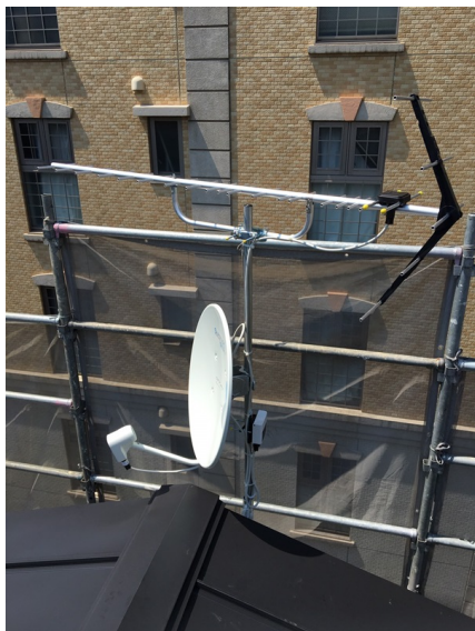
江東区北砂 壁面取付 地デジアンテナとBSアンテナ工事
