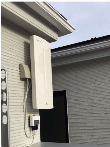
江東区東砂 壁面取付 デザインアンテナ工事
