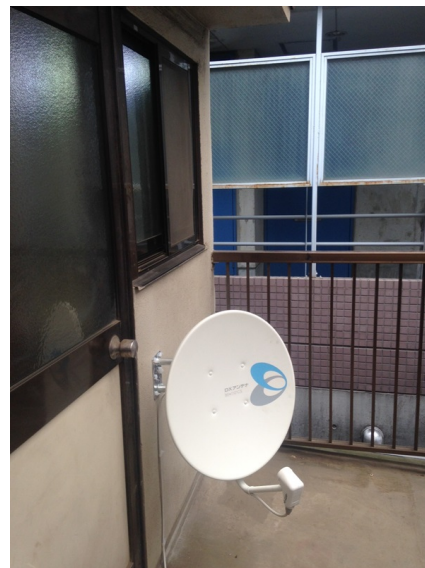
江東区亀戸 壁面取付 地デジアンテナ工事
