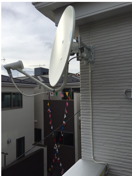
江東区東砂 壁面取付 BSアンテナ工事
