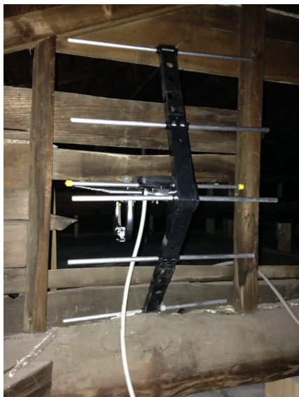
江東区亀戸 地デジアンテナ屋根裏工事
