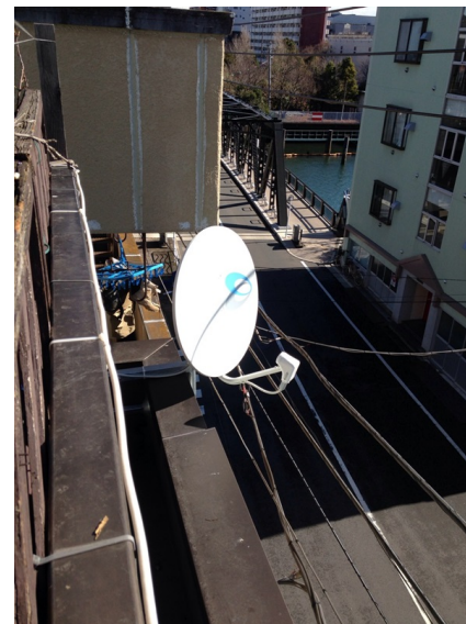
江東区平野 BSアンテナ挟み込み工事
