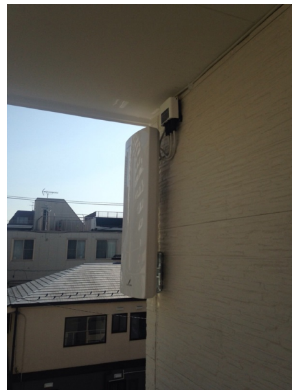
江東区森下 壁面取付 デザインアンテナ工事
