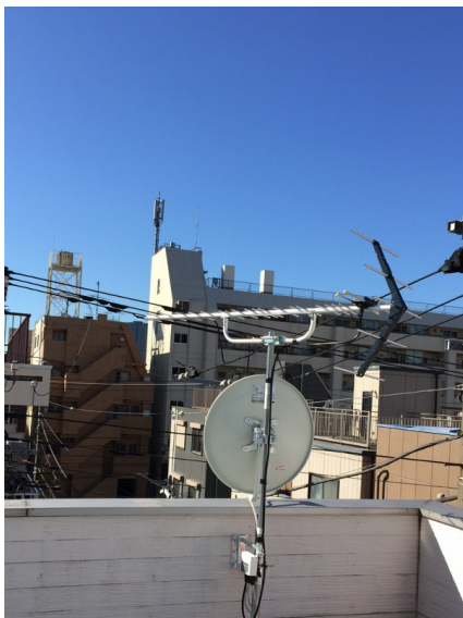
江東区古石場 壁面取付 地デジアンテナとBSアンテナ工事
