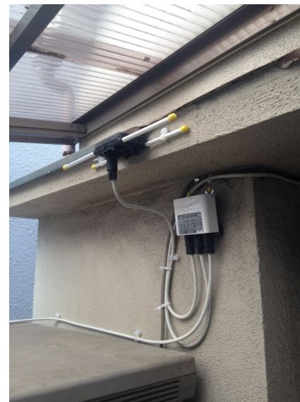
江東区亀戸 壁面取付 BSアンテナ工事
