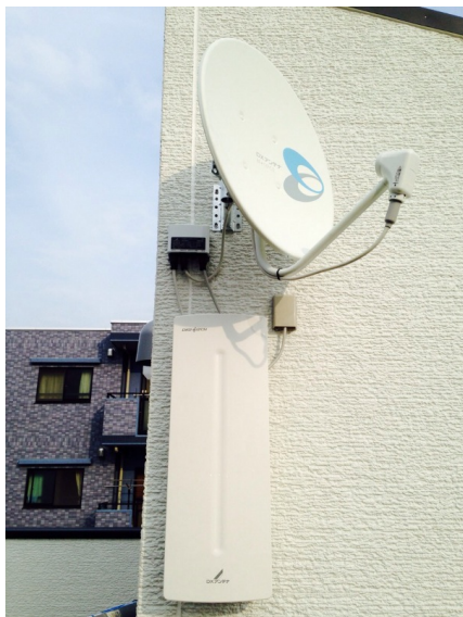
江東区東砂 壁面取付 デザインアンテナとBSアンテナ工事
