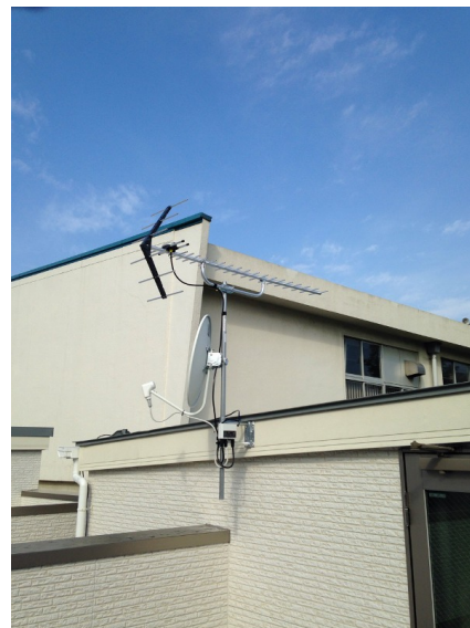
江東区東陽 壁面取付 地デジアンテナとBSアンテナ工事
