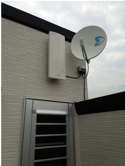
江東区大島 壁面取付 デザインアンテナとBSアンテナ工事
