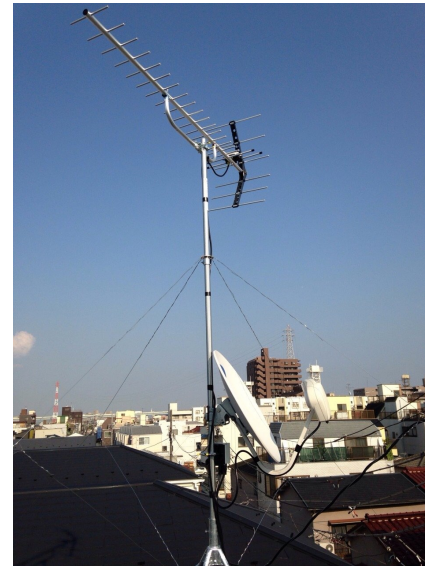
江東区東砂 地デジアンテナとBSアンテナ屋根上工事
