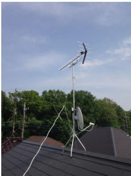
小平市上水新町 地デジアンテナとBSアンテナ屋根上工事
