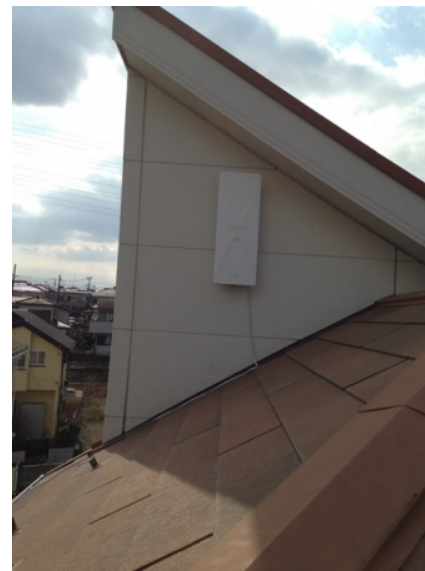
小平市栄町 壁面取付 デザインアンテナ工事
