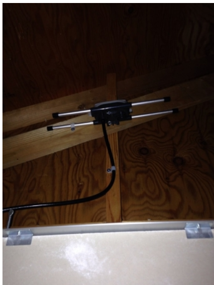
東京都北区中十条 地デジアンテナ屋根裏工事
