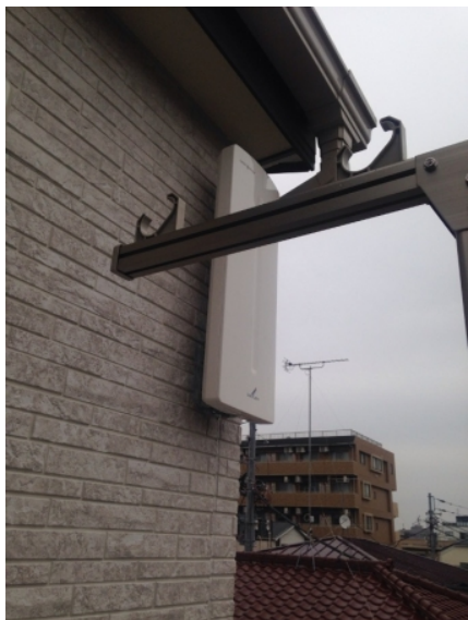
東京都北区中十条 壁面取付 デザインアンテナ 工事
