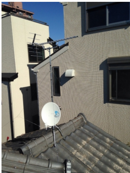
東京都北区上十条 地デジアンテナとBSアンテナ屋根上工事
