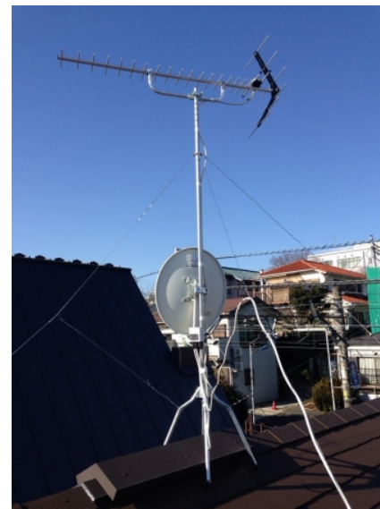
東京都北区滝野川 地デジアンテナとBSアンテナ屋根上工事
