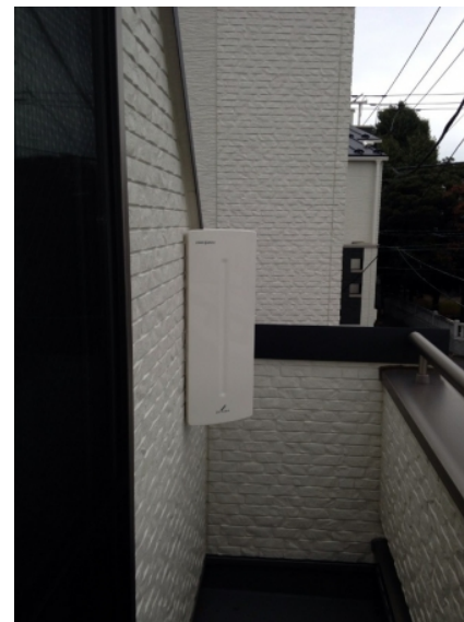
東京都北区浮間 壁面取付 デザインアンテナ工 事
