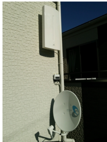
東京都北区王子壁面取付デザインアンテナとBS アンテナ工事
