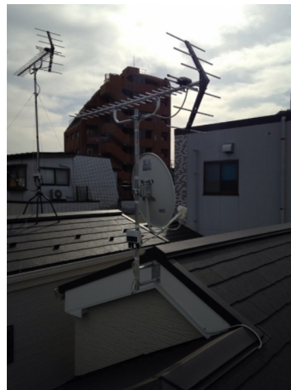
東京都北区浮間 壁面取付 地デジアンテナとBSアンテナ工事
