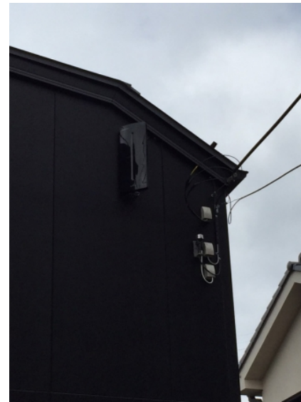
青梅市新町 壁面取付 デザインアンテナ工事
