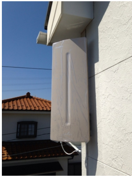
青梅市木野下 壁面取付 デザインアンテナ工事
