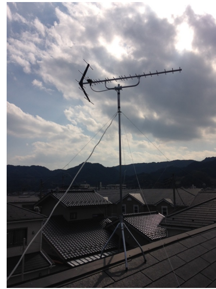
青梅市梅郷 アーネストワン様物件 地デジアンテナ屋根上工事
