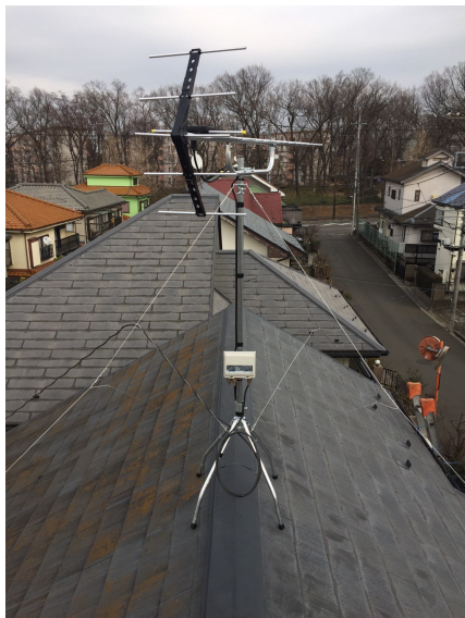
清瀬市旭が丘 屋根上設置 八木式アンテナ本体交換工事
