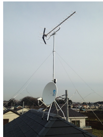
清瀬市梅園 一条工務店様物件 地デジアンテナとBSCSアンテナの屋根上工事
