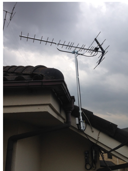
清瀬市下宿 一建設様物件 地デジアンテナの破風板設置
