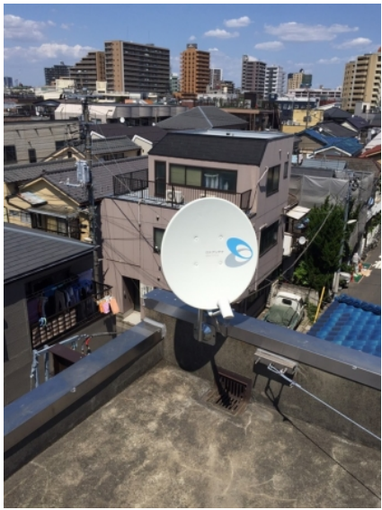
葛飾区四つ木 地デジアンテナとBSアンテナ挟み込み工事
