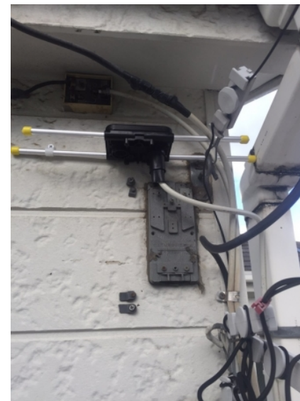
葛飾区奥戸 壁面取付 地デジアンテナ工事
