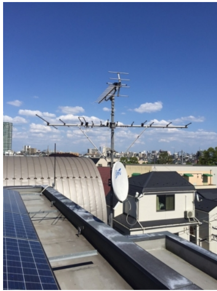
葛飾区四つ木 地デジアンテナ追加工事
