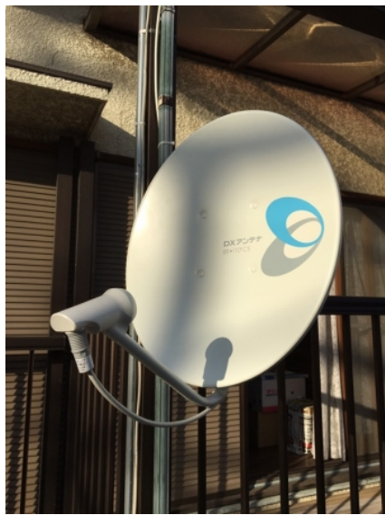
葛飾区東四つ木 BSアンテナ追加工事
