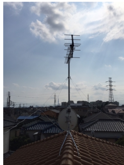
葛飾区立石 地デジアンテナ工事後の外観
