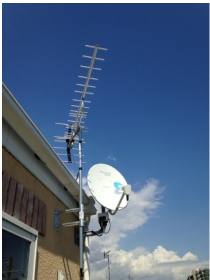
葛飾区新小岩 壁面取付 地デジアンテナとBSアンテナ工事
