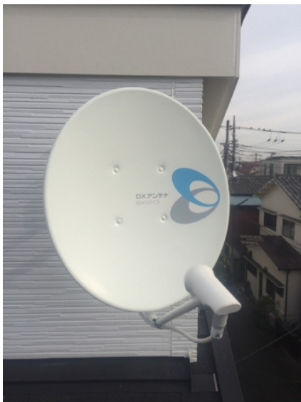
葛飾区新宿 壁面取付 BSアンテナ工事
