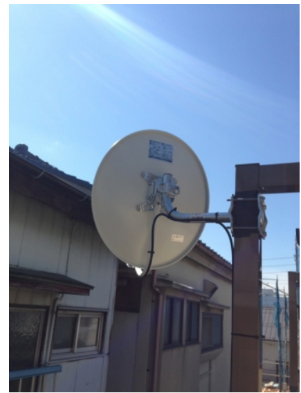
葛飾区堀切 BSアンテナ工事
