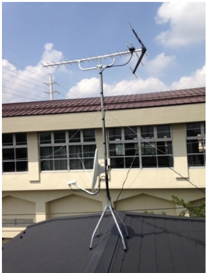
葛飾区亀有 地デジアンテナとBSアンテナ屋根上工事
