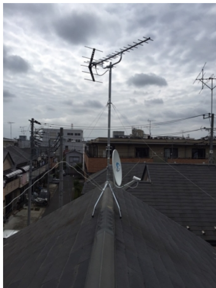
葛飾区柴又 地デジアンテナとBSアンテナ屋根上工事
