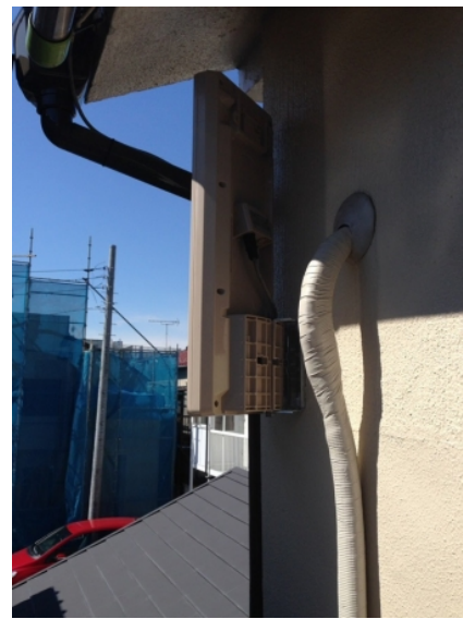
葛飾区堀切 壁面取付 デザインアンテナ工事
