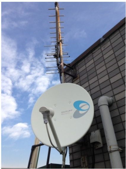
葛飾区立石 BSアンテナ追加工事
