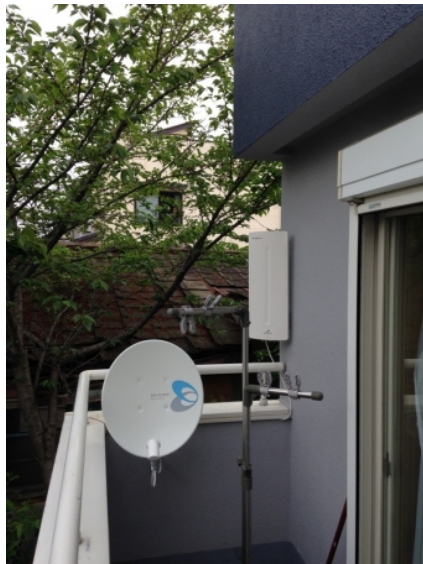
葛飾区四つ木 地デジアンテナ屋根裏工事
