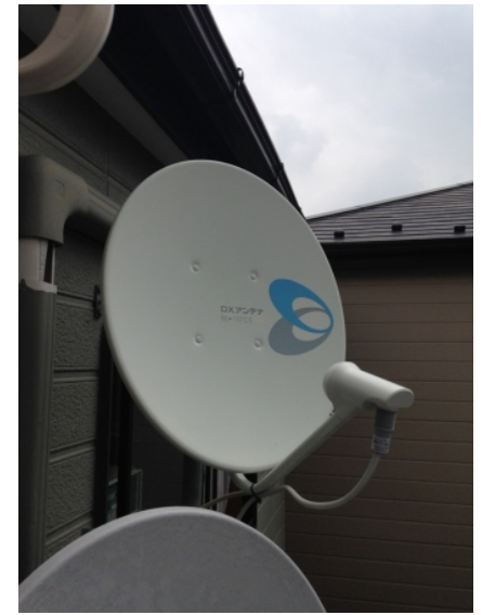
葛飾区柴又 壁面取付 BSアンテナ工事
