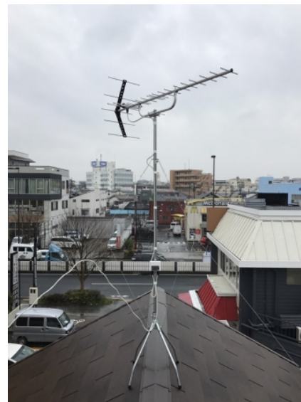
葛飾区白鳥 地デジアンテナ屋根上工事
