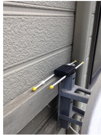
葛飾区柴又 地デジアンテナ工事
