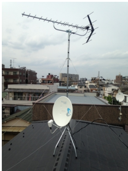
葛飾区新小岩 地デジアンテナとBSアンテナ屋 根上工事
