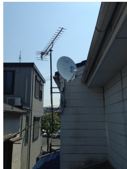
葛飾区東新小岩 壁面取付 BSアンテナ追加工 事
