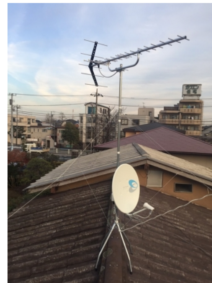
葛飾区東金町 地デジアンテナとBSアンテナ屋根上工事
