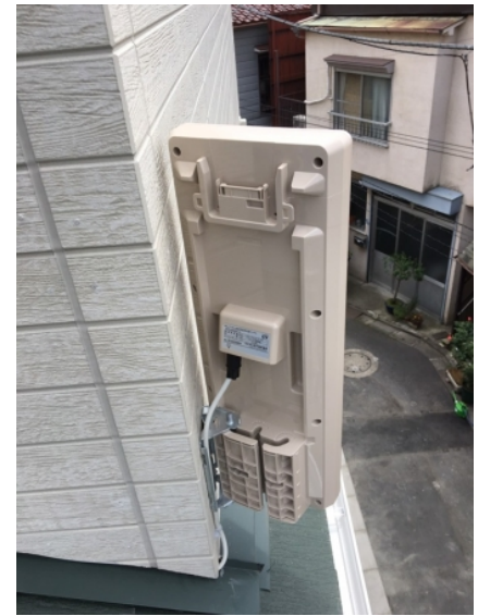
葛飾区東四つ木 壁面取付 デザインアンテナ工事
