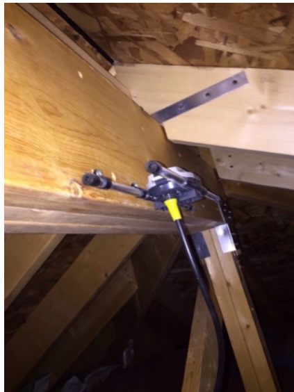
葛飾区新宿 ポラス様物件 地デジアンテナ屋根裏工事
