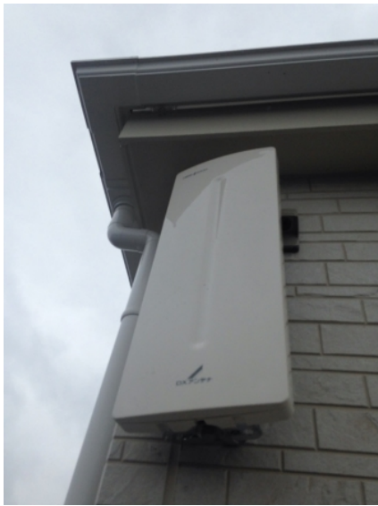
葛飾区金町 飯田産業様物件 壁面取付 デザインアンテナ工事
