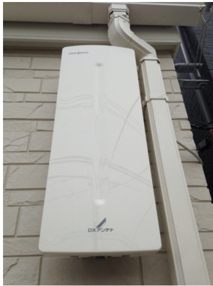
葛飾区小菅 マイライフプランニング様物件 壁面取付 デザインアンテナ工事
