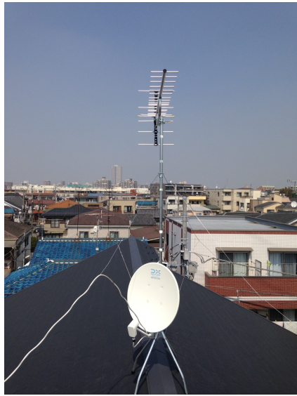
葛飾区高砂 ウルテック様ご物件 屋根上設置 八木式アンテナとBS/CSアンテナ
