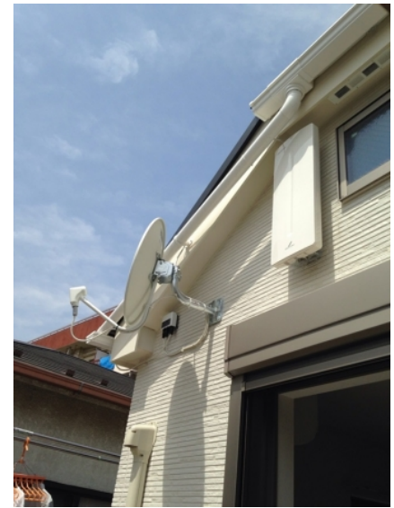
葛飾区堀切 飯田産業様物件 壁面取付 デザインアンテナとB Sアンテナ工事
