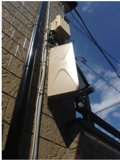
葛飾区亀有 壁面取付 デザインアンテナ工事
