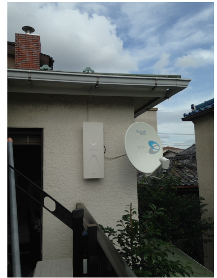
葛飾区金町 壁面取付 デザインアンテナとBSアンテナ工事
