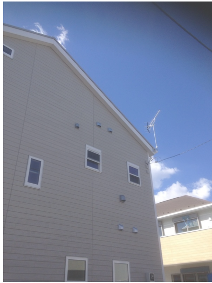
昭島市緑町 住友不動産様物件 地デジアンテナ工事後の外観
