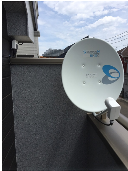
昭島市緑町 壁面取付 BSアンテナ工事
