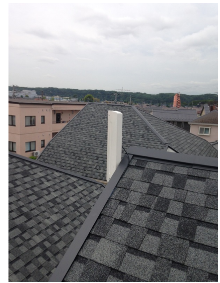
昭島市福島町 タクトホーム様物件 地デジアンテナ工事後の外観
