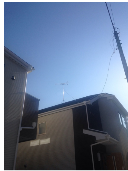
昭島市拝島町 地デジアンテナ工事後の外観
