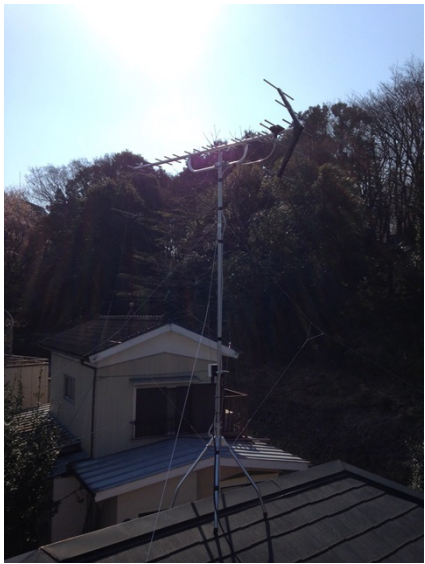
昭島市朝日町 古河林業様物件 地デジアンテナ屋根上工事
