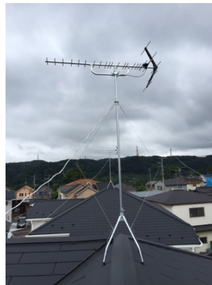
あきる野市引田 はじめ建設様物件 地デジアンテナ屋根上工事
