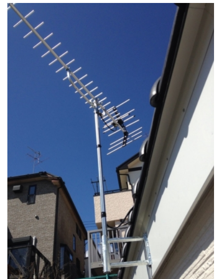
あきる野市平沢 壁面取付 地デジアンテナ工事
