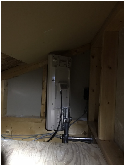
足立区千住 デザインアンテナ屋根裏工事
