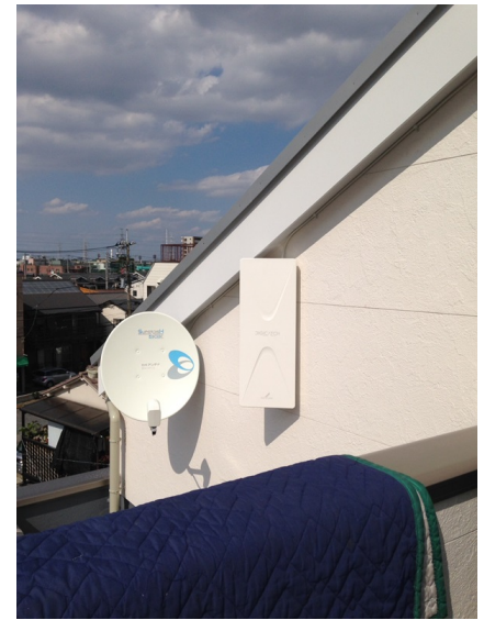
足立区港北 壁面取付 デザインアンテナとBSアンテナ工事
