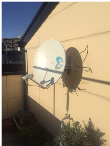
足立区東和 壁面取付 BSアンテナ工事
