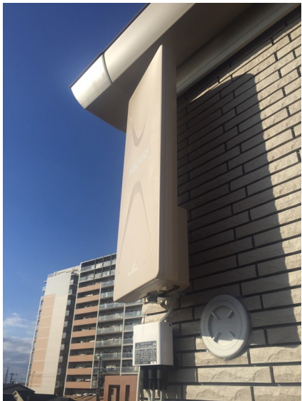
足立区西新井栄町 壁面取付 デザインアンテナ工事
