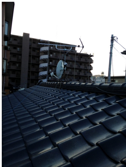
足立区東和 地デジアンテナとBSアンテナ交換 工事
