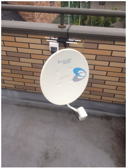
足立区加平 壁面取付 地デジアンテナとBSアンテナ工事
