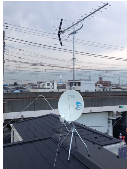
足立区中川 地デジアンテナとBSアンテナ屋根 上工事
