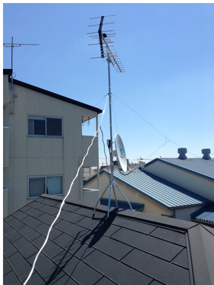
足立区入谷 地デジアンテナとBSアンテナ屋根 上工事
