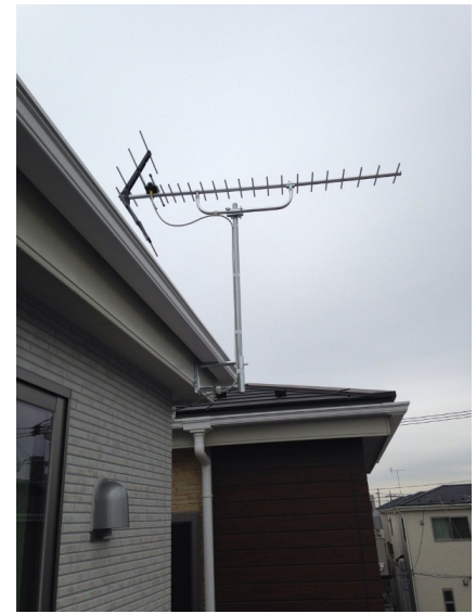
足立区興野 壁面取付 地デジアンテナ工事
