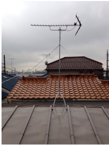
足立区舎人 地デジアンテナ屋根上工事
