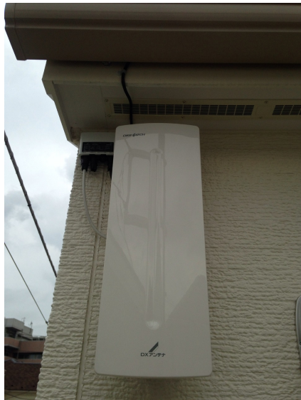
足立区保木間 壁面取付 デザインアンテナ工事
