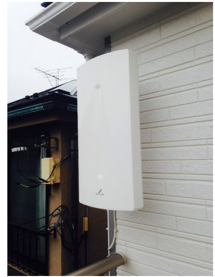
足立区椿 壁面取付 デザインアンテナ工事
