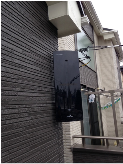
足立区梅田 サンウエストホーム様物件 壁面取付 デザインアンテナ工事
