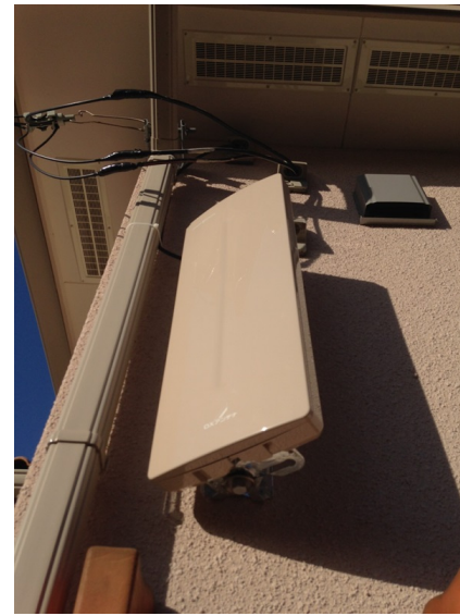
足立区西新井 ポラス様物件 壁面取付 デザインアンテナ工事
