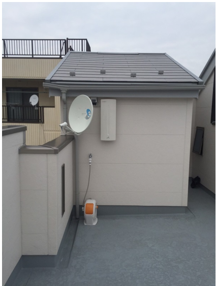
足立区梅田 サンウエストホーム様物件 壁面取付 デザインアンテナとBSアンテナ工事
