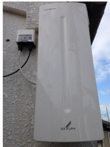
富士見市渡戸 壁面取付 デザインアンテナ工事
