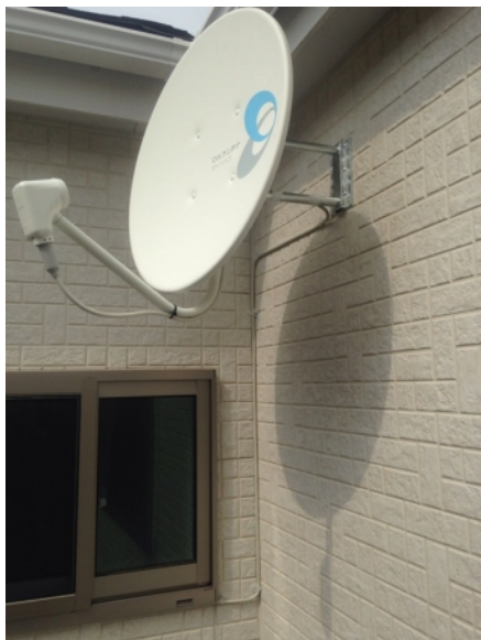
富士見市羽沢 飯田産業様物件 壁面取付 BSアンテナ工事
