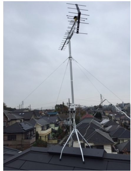
富士見市水子 アペルト様物件 地デジアンテナ屋根上工事
