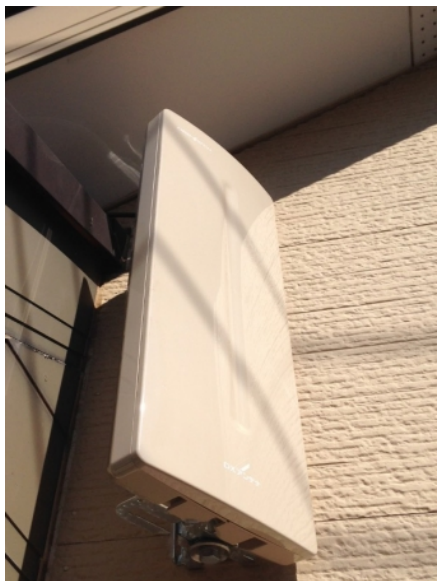
富士見市上沢 壁面取付 デザインアンテナ工事
