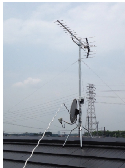
富士見市水子 積水ハウス様物件 地デジアンテナとBSアンテナ屋根上工事
