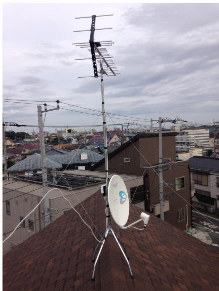
富士見市関沢 アットナチュレ様物件 地デジアンテナとBSアンテナ屋根上工事
