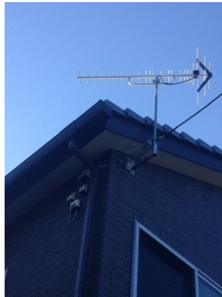
富士見市上沢 クレバリーホーム様物件 壁面取付 地デジアンテナ工事
