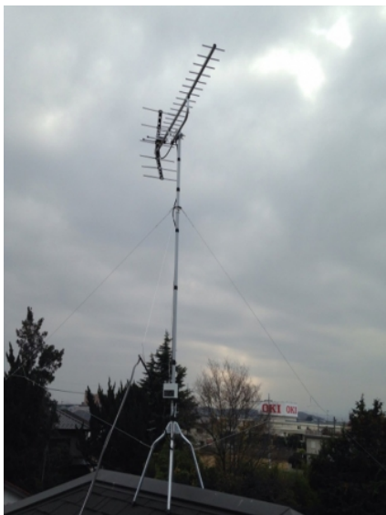
本庄市小島 地デジアンテナ屋根上工事
