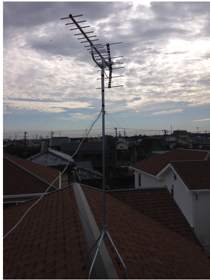
本庄市見福 地デジアンテナ屋根上工事
