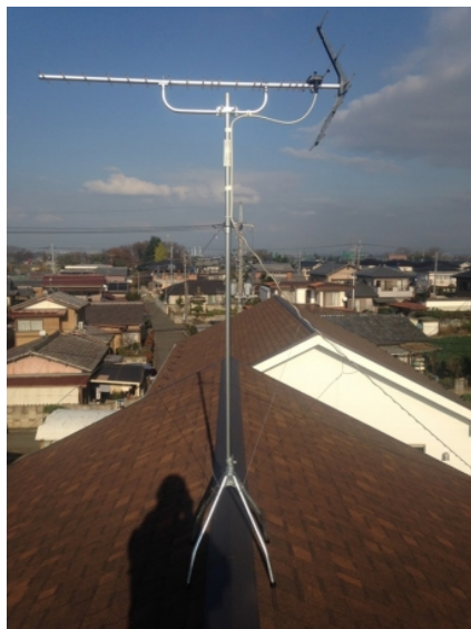
本庄市小島 ケイアイスター不動産様物件 地デジアンテナ屋根上工事
