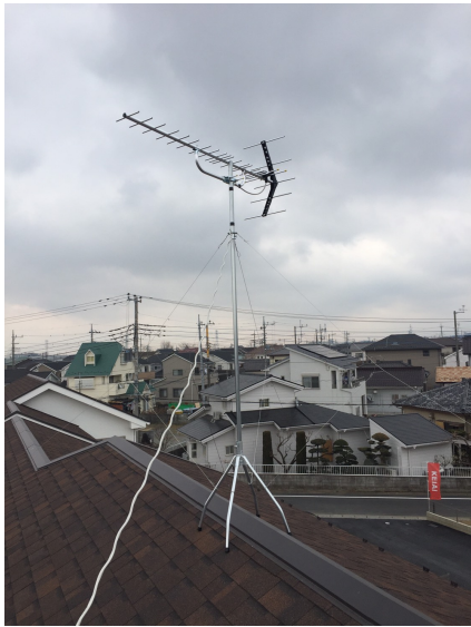
本庄市児玉町児玉 ケイアイスター様ご物件 屋根上設置 八木式アンテナ工事
