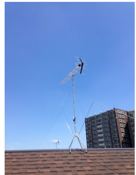
本庄市駅南 ケイアイスター不動産様物件 地デジアンテナ屋根上工事
