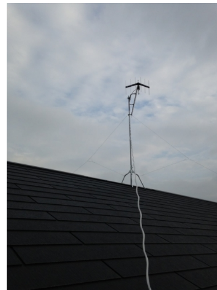
本庄市児玉町入浅見 垂直偏波受信 地デジアンテナ屋根上工事
