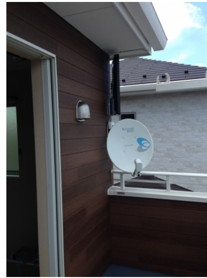
ふじみ野市亀久保 住協建設様物件 壁面取付 デザインアンテナとBSアンテナ工事
