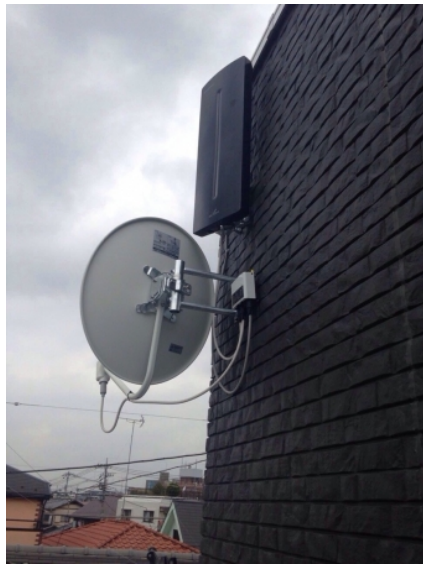
ふじみ野市上福岡 壁面取付 デザインアンテナとBSアンテナ工事
