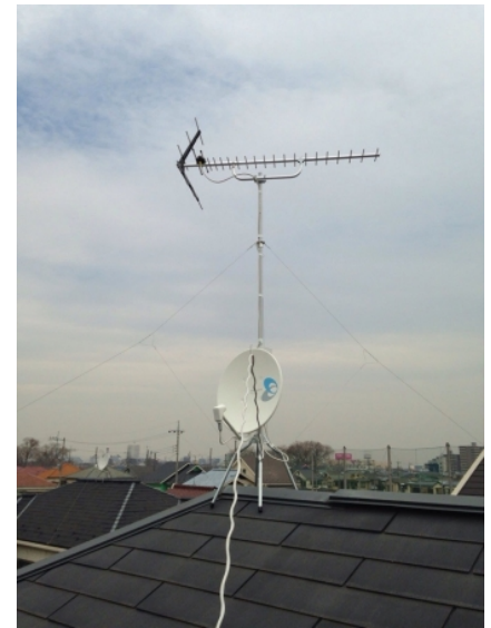
ふじみ野市亀久保 地デジアンテナとBSアンテナ屋根上工事
