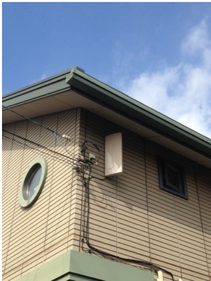
ふじみ野市うれし野 セキスイハイム様物件 壁面取付 デザインアンテナ工事
