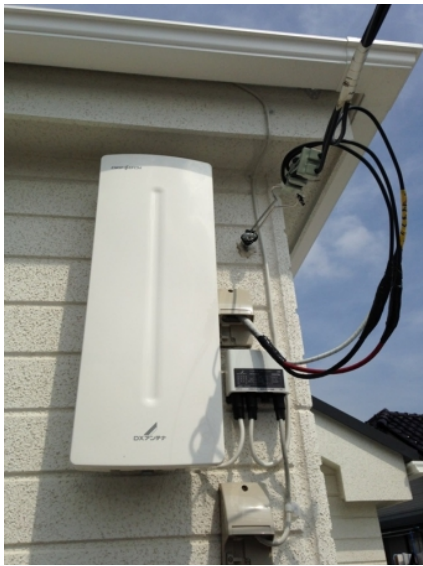
ふじみ野市大井中央 タクトホーム様物件 壁面取付 デザインアンテナ工事
