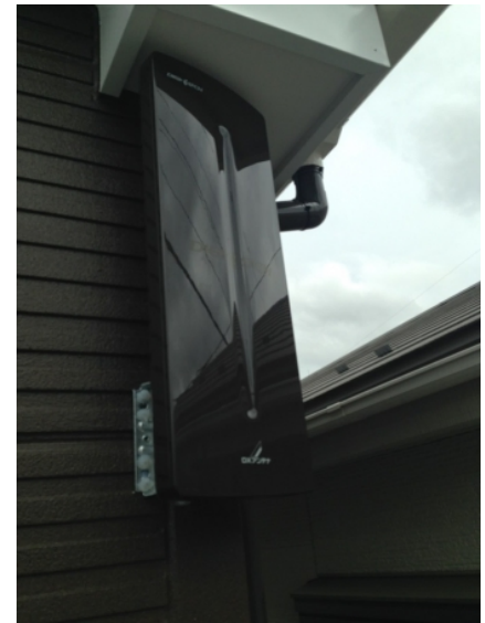
ふじみ野市南台 千代田ホーム様物件 壁面取付 デザインアンテナ工事
