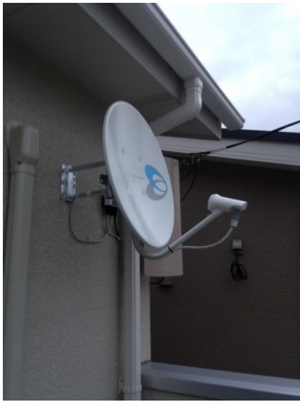
ふじみ野市鶴ヶ丘 タカラレーベン様物件 壁面取付 デザインアンテナとBSアンテナ工事
