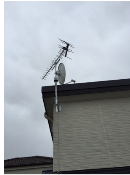
ふじみ野市駒林間元町 アキュラホーム様物件 壁面取付 地デジアンテナとBSアンテナ工事
