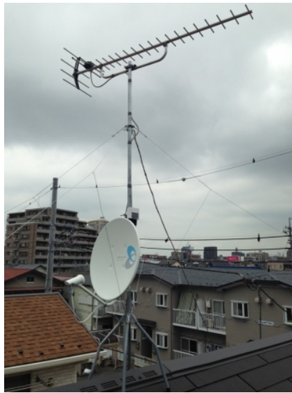
ふじみ野市福岡武蔵野 住協建設様物件 地デジアンテナとBSアンテナ屋根上工事
