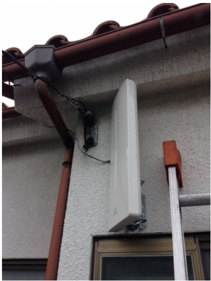
ふじみ野市苗間 壁面取付 デザインアンテナ工事
