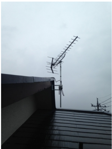
ふじみ野市福岡中央 壁面取付 地デジアンテナ工事
