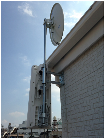
ふじみ野市北野 壁面取付 デザインアンテナとBSアンテナ工事
