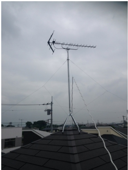
ふじみ野市駒林 住協建設様物件 地デジアンテナ屋根上工事
