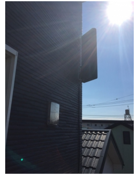
ふじみ野市西 壁面取付 デザインアンテナ工事
