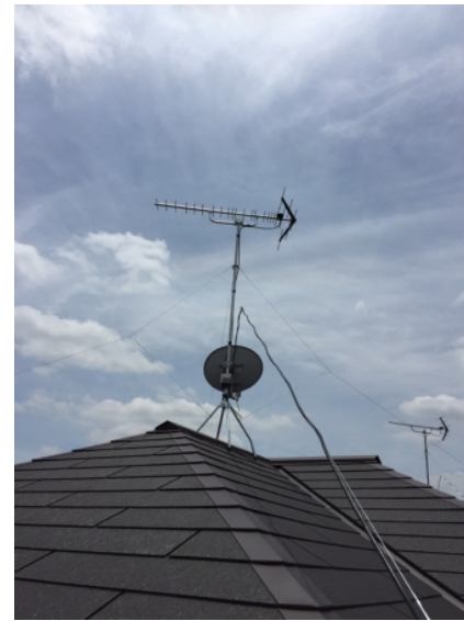
ふじみ野市西原 住協建設様物件 地デジアンテナとBSアンテナ屋根上工事
