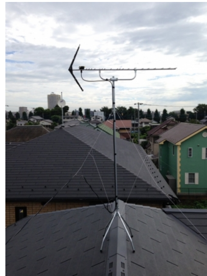
ふじみ野市鶴ヶ岡 住協建設様物件 地デジアンテナ屋根上工事
