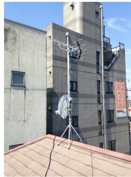
ふじみ野市うれし野 地デジアンテナとBSアンテナ屋根上工事
