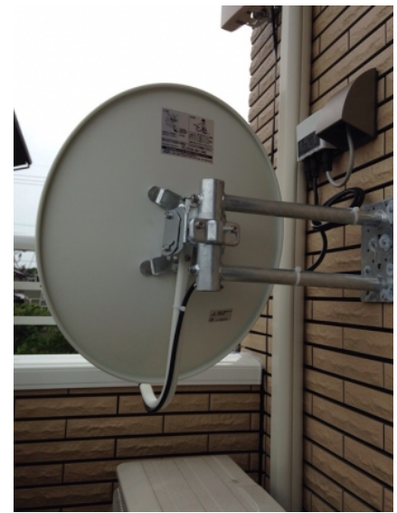
ふじみ野市市沢 一条工務店様物件 壁面取付 BSアンテナ工事
