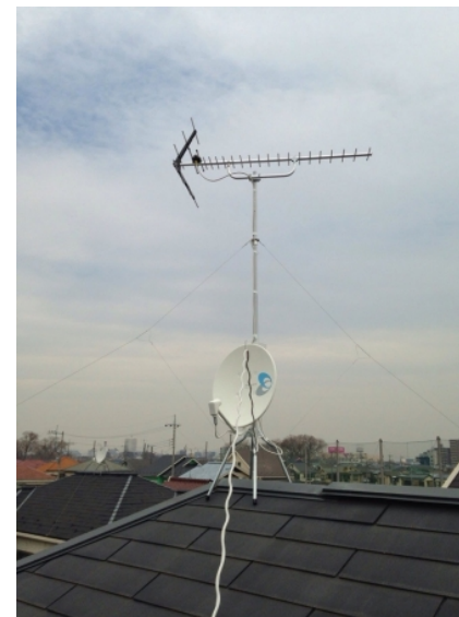
ふじみ野市亀久保 地デジアンテナとBSアンテナ屋根上工事
