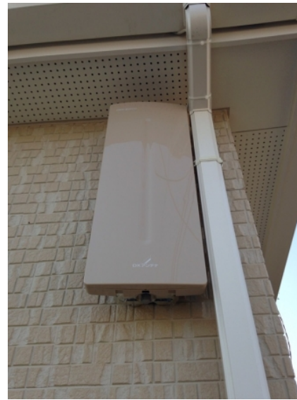
ふじみ野市西原 住協建設様物件 壁面取付 デザインアンテナ工事
