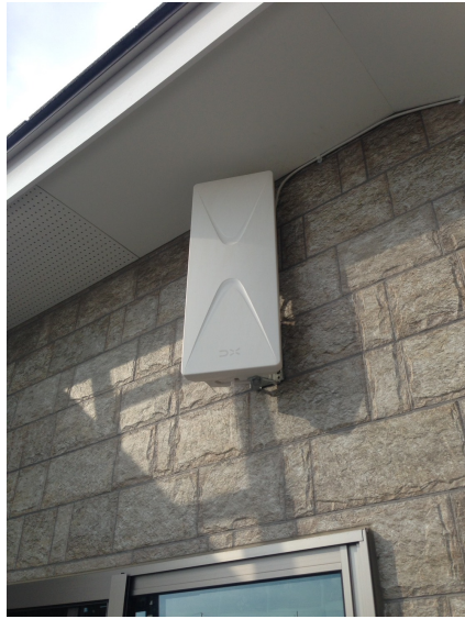
ふじみ野市亀久保 壁面取付 デザインアンテナ工事
