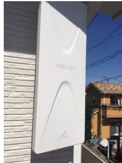
ふじみ野市亀久保 住協建設様物件 壁面取付 デザインアンテナ工事
