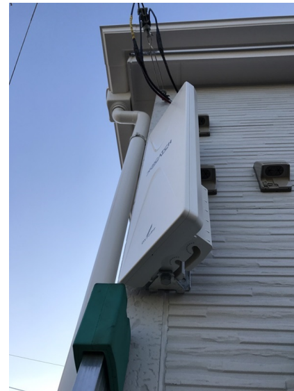
所沢市上安松 壁面取付 デザインアンテナ工事
