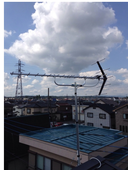
所沢市若狭 壁面取付 地デジアンテナ工事
