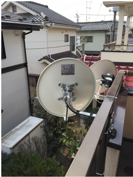
所沢市青葉台 ベランダ取付 B S アンテナ工事
