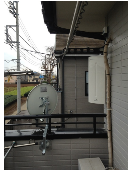
所沢市下富 デザインアンテナとBSアンテナ工 事
