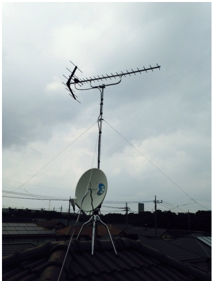
所沢市中富南 地デジアンテナとBSアンテナ屋 根上工事
