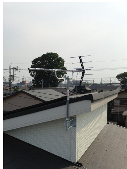
所沢市山口 地デジアンテナとBSアンテナ屋根上工事
