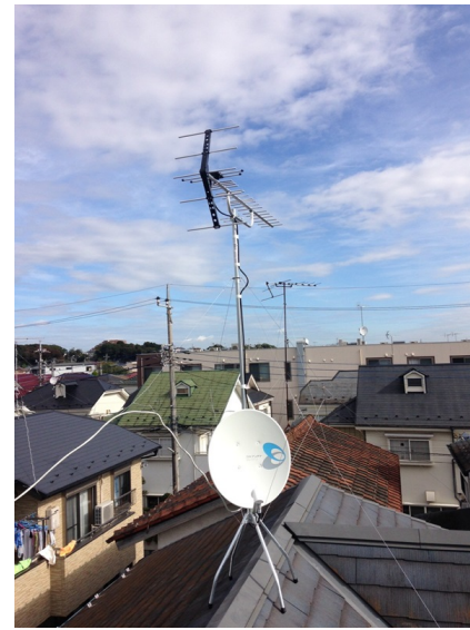
所沢市下安松 地デジアンテナとBSアンテナ屋 根上工事
