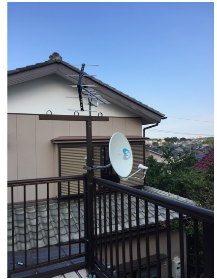
所沢市上安松 地デジアンテナとBSアンテナ工事
