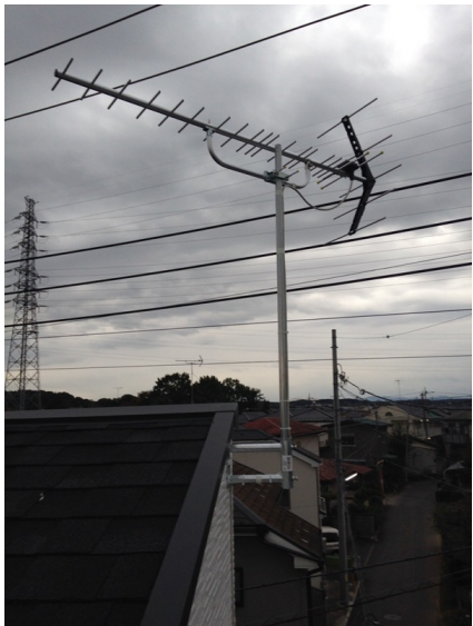
所沢市山口 壁面取付 地デジアンテナ工事
