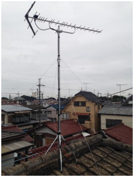
新座市石神 地デジアンテナ屋根上工事
