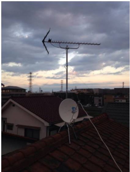
新座市栄 地デジアンテナとBSアンテナ屋根上 工事
