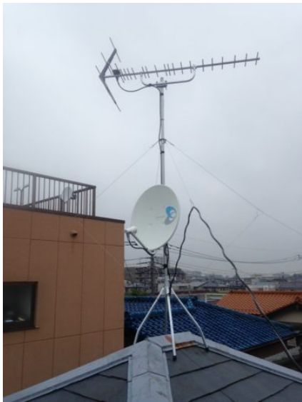
新座市新座 地デジアンテナとBSアンテナ屋根上工事
