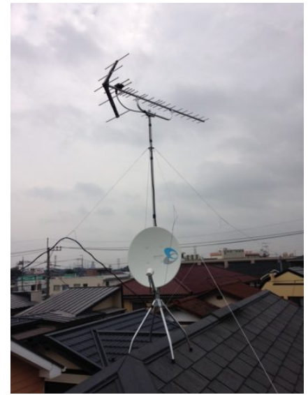
新座市野寺 地デジアンテナとBSアンテナ屋根上工事
