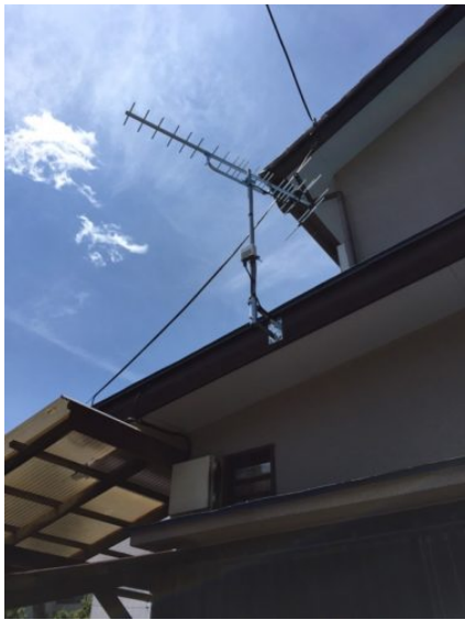
新座市野寺 壁面取付 地デジアンテナ工事
