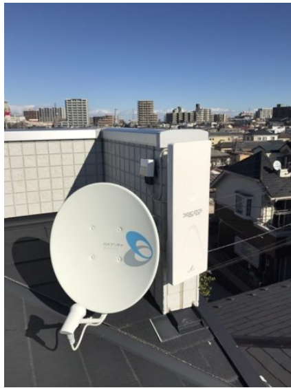
新座市東 壁面取付 デザインアンテナとBSアンテナ工事
