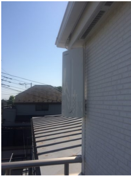
新座市畑中 壁面取付 デザインアンテナ工事
