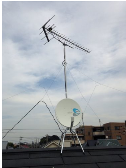
新座市馬場 地デジアンテナとBSアンテナ工事
