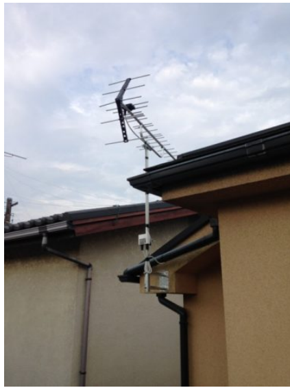
新座市馬場 壁面取付 地デジアンテナ工事
