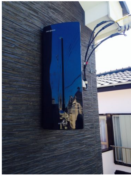
新座市馬場 壁面取付 デザインアンテナ工事
