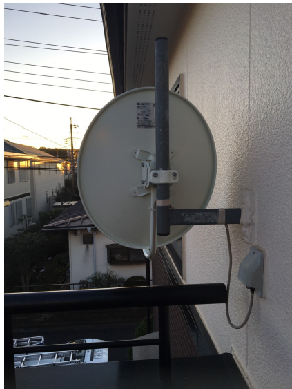
新座市あたご 壁面取付 BSアンテナ工事
