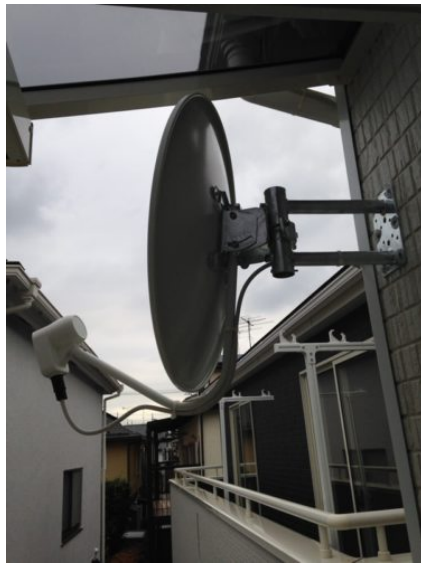
新座市畑中 アーネストワン様物件 壁面取付 BSアンテナ工事
