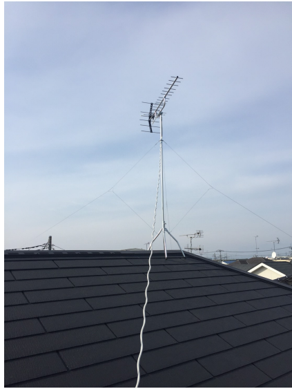
新座市野火止 屋根上設置 八木式アンテナ工事
