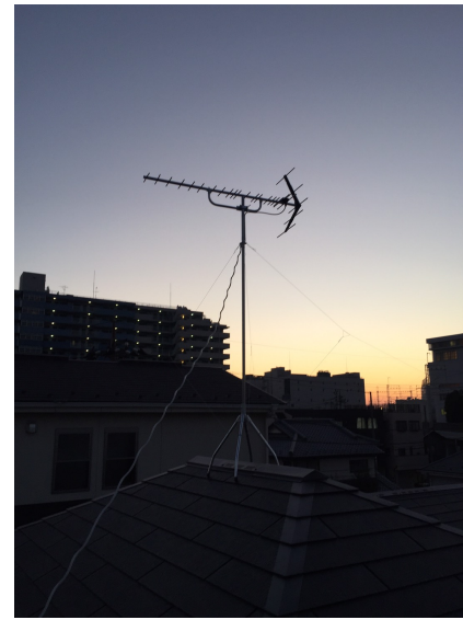
新座市野火止 住協建設様物件 地デジアンテナ屋根上工事
