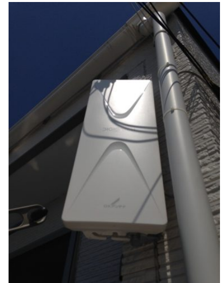
新座市畑中 壁面取付 デザインアンテナ工事
