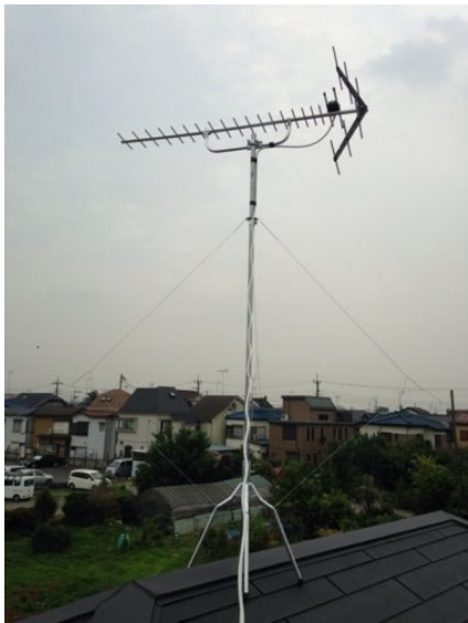
新座市栄 一建設様物件 地デジアンテナ屋根上工事
