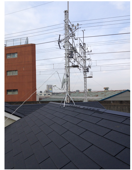
新座市野火止 住協様ご物件 屋根上設置 八木式アンテナ工事
