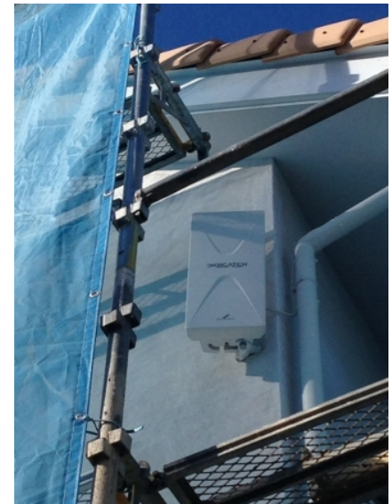
東松山市加美町 シバタスペース様物件 壁面取付 デザインアンテナ工事
