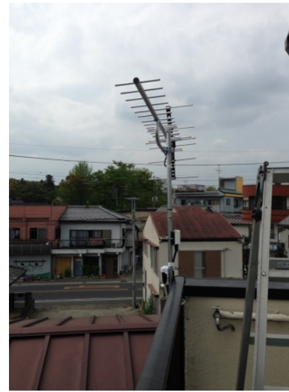
東松山市箭弓町 壁面取付 地デジアンテナ工事
