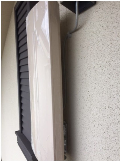
東松山市下唐 一条工務店様物件 壁面取付 デザインアンテナ工事
