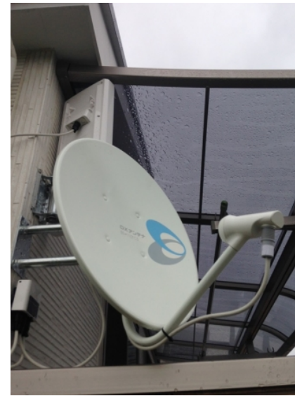
東松山市加美町 壁面取付 BSアンテナ工事
