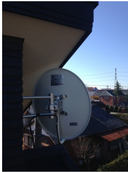
東松山市石橋 アイ工務店様物件 壁面取付 BSアンテナ工事
