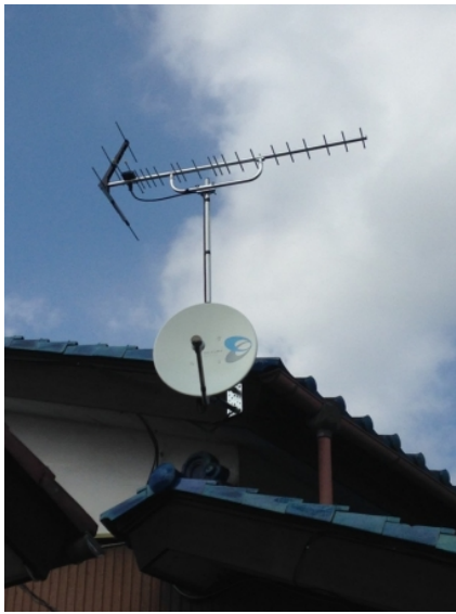
東松山市正代 壁面取付 地デジアンテナとBSアンテナ工事
