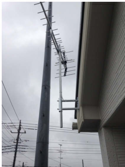
蓮田市緑町 東栄住宅様物件 壁面取付 地デジアンテナ工事
