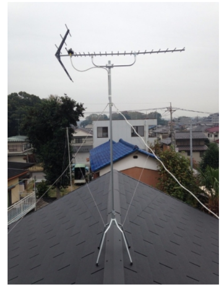
蓮田市上 地デジアンテナ屋根上工事
