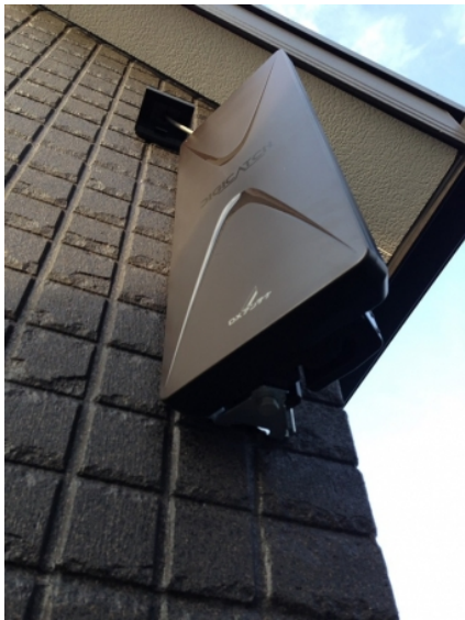
蓮田市黒浜 開成コーポレーション様物件 壁面取付 デザインアンテナ工事
