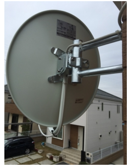
蓮田市城 山岸工業様物件 壁面取付 BSアンテナ工事
