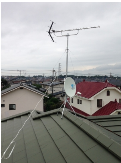
蓮田市椿山 山岸工業様物件 地デジアンテナとBSアンテナ屋根上工事
