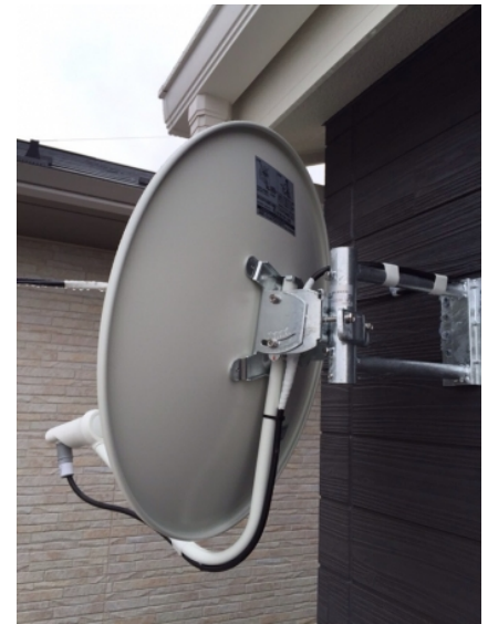
蓮田市馬込 壁面取付 B S アンテナ工事
