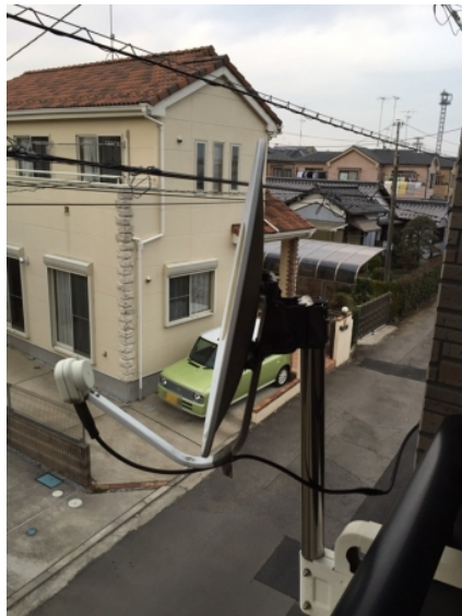
蓮田市関山 バランダ取付 BSアンテナ工事
