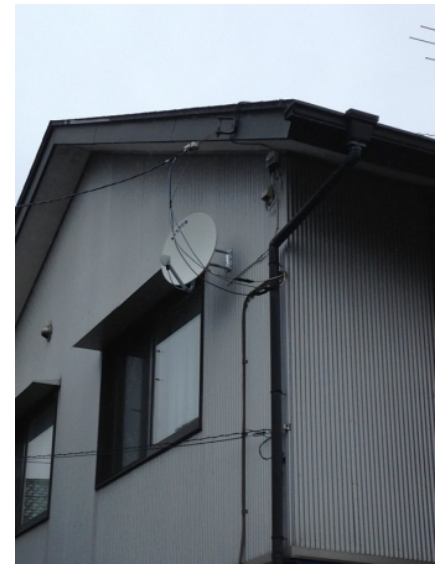
蓮田市椿山 壁面取付 持ち込みBSアンテナ工事
