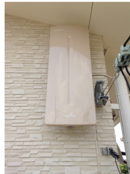
蓮田市馬込 アキュラホーム様物件 壁面取付 デザインアンテナ工事
