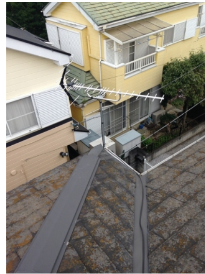
蓮田市黒浜 壁面取付 地デジアンテナ工事
