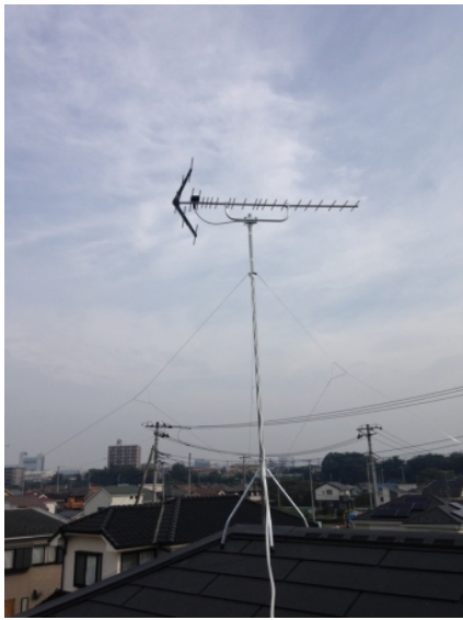
飯能市征矢町 地デジアンテナ屋根上工事
