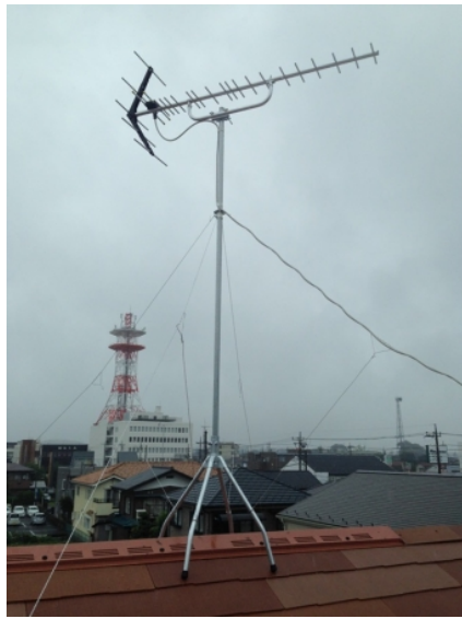
飯能市栄町 西部設計様物件 地デジアンテナ屋根上工事
