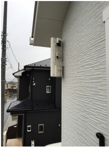
飯能市中山 住協建設様物件 壁面取付 デザインアンテナ工事
