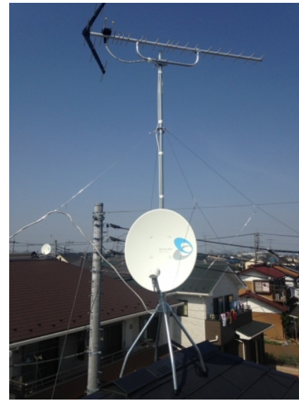
飯能市双柳 住協建設様物件 地デジアンテナとBSアンテナ屋根上工事
