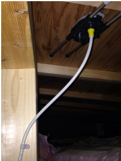
草加市小山 永大様物件 地デジアンテナ屋根裏工事
