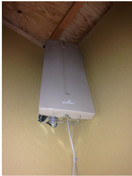
草加市北谷 永大様物件 デザインアンテナ屋根裏工事
