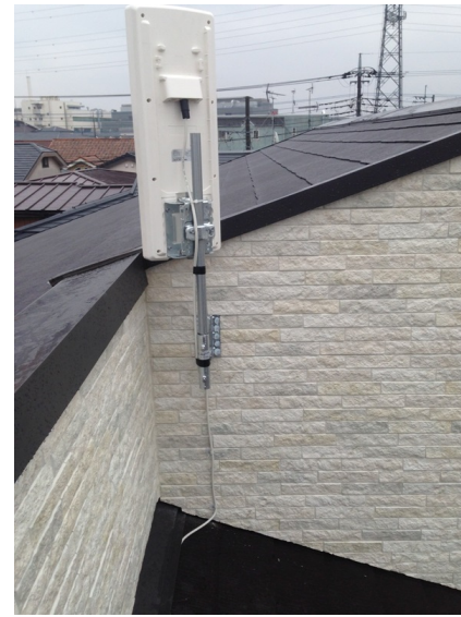
志木市幸町 壁面取付 デザインアンテナ工事
