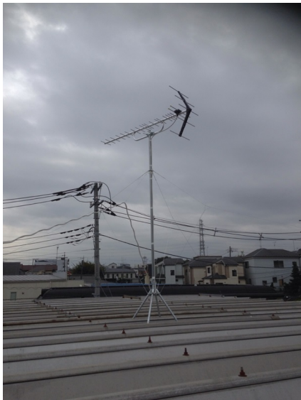
志木市本町 地デジアンテナ屋根上工事
