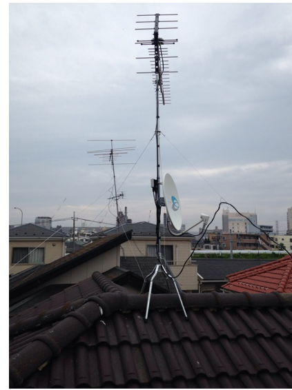
志木市柏町 地デジアンテナとBSアンテナ屋根上工事
