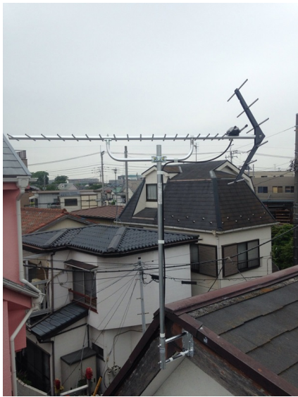
志木市下宗岡 壁面取付 地デジアンテナ工事
