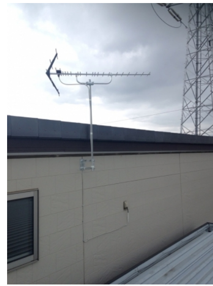
狭山市水野 壁面取付 地デジアンテナ工事
