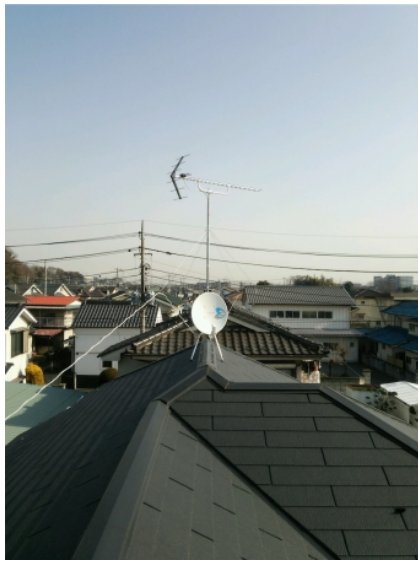
狭山市広瀬 地デジアンテナとBSアンテナ屋根上工事
