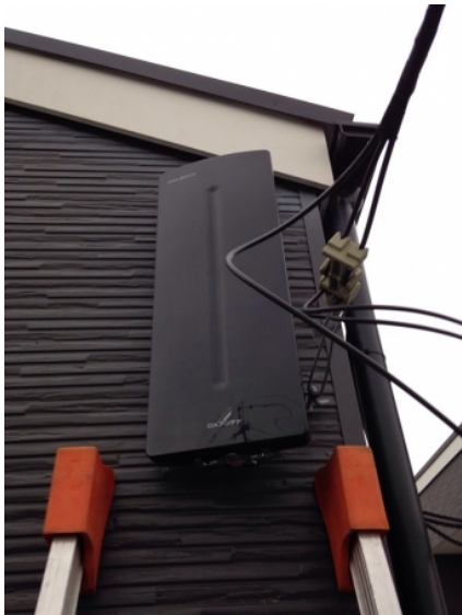
狭山市水野 壁面取付 デザインアンテナ工事
