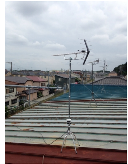
狭山市入間川 地デジアンテナ屋根上工事
