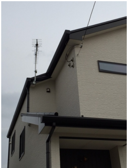
狭山市東三ツ木 住協建設様物件 壁面取付 地デジアンテナ工事
