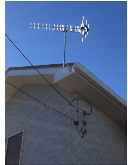
狭山市水野 住協建設様物件 壁面取付 地デジアンテナ工事
