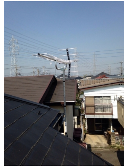
狭山市上奥富 壁面取付 地デジアンテナ工事
