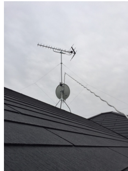
狭山市水野 ホークワン様物件 地デジアンテナとBSアンテナ屋根上工事
