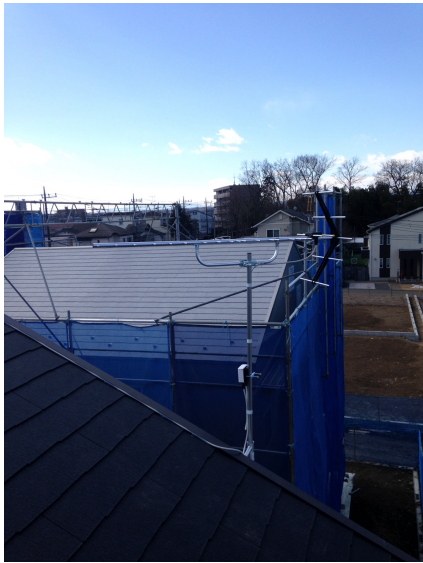
狭山市水野 近藤建設様ご物件 破風板取付 八木式アンテナ工事
