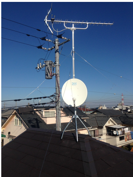
狭山市中央 住協建設様ご物件 屋根上設置 八木式アンテナとBS/CSアンテナ工事
