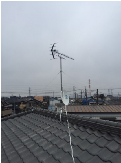
坂戸市中小阪 地デジアンテナとBSアンテナ屋根上工事
