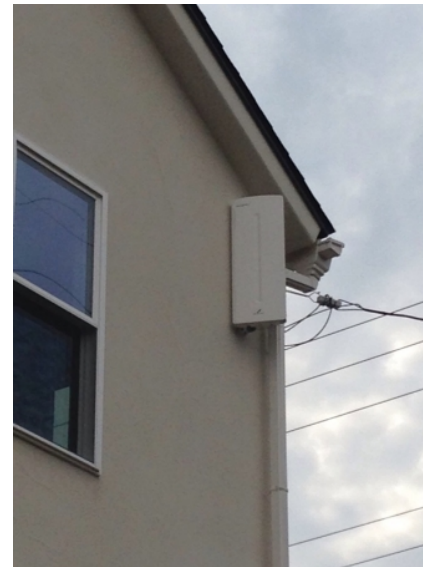
坂戸市小沼 壁面取付 デザインアンテナ工事
