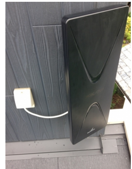
坂戸市新堀 桧家住宅様物件 壁面取付 デザインアンテナ工事
