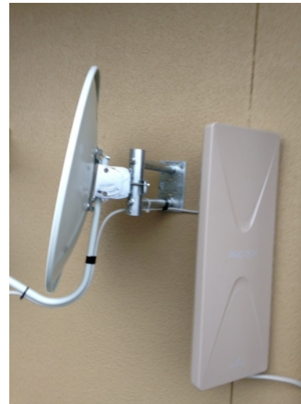
坂戸市鶴舞 壁面取付 BSアンテナ追加工事
