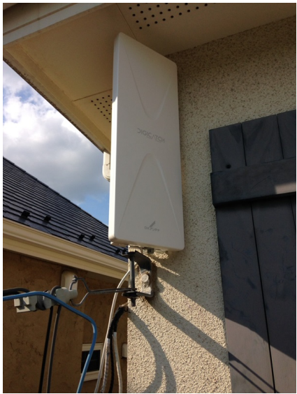
さいたま市見沼区春野 壁面取付 デザインアンテナ工事
