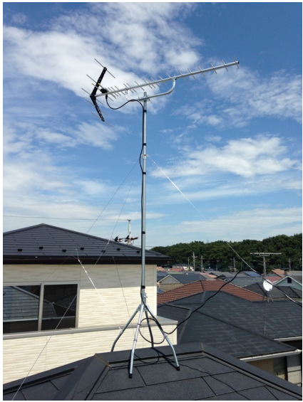
さいたま市見沼区丸ヶ崎町 地デジアンテナ屋根 上工事
