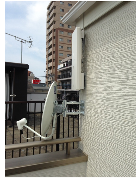
さいたま市見沼区東大宮 壁面取付 デザインアンテナとBSアンテナ工事
