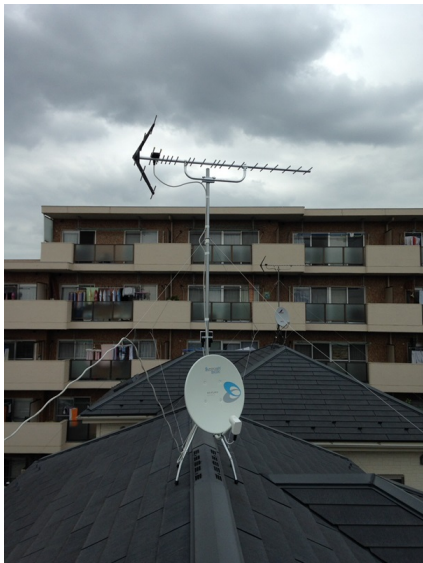
さいたま市見沼区東大宮 地デジアンテナとBSアンテナ屋根上工事
