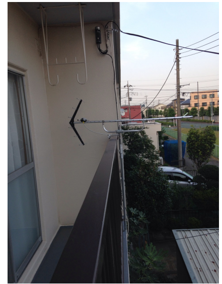
さいたま市見沼区堀崎町 地デジアンテナフェンス工事
