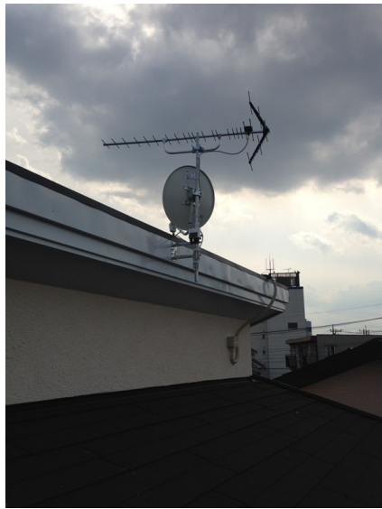
さいたま市見沼区堀崎町 北洲ハウジング様物件 壁面取付 地デジアンテナとBSアンテナ工事
