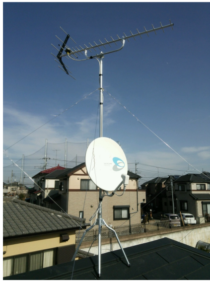
さいたま市見沼区南中丸 地デジアンテナとBSアンテナ屋根上工事
