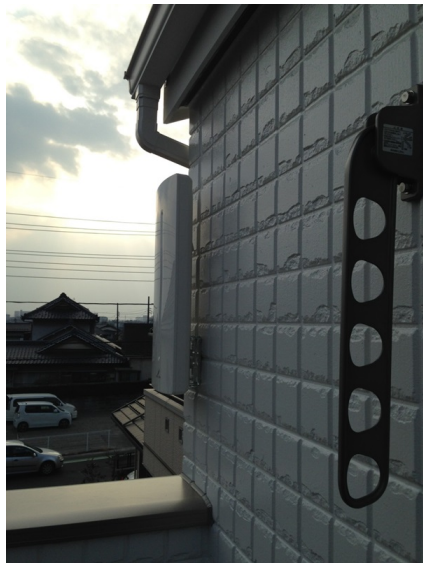
さいたま市見沼区東大宮 大熊工務店様物件 壁面取付 デザインアンテナ工事
