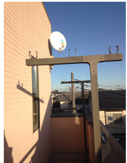
さいたま市見沼区 小林ハウジング様ご物件 壁面取付 BSアンテナ移設工事
