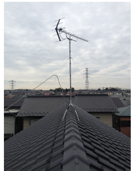
見沼区春岡 屋根上設置 八木式アンテナ工事
