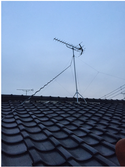
さいたま市見沼区南中丸 屋根上設置 八木式アンテナ工事
