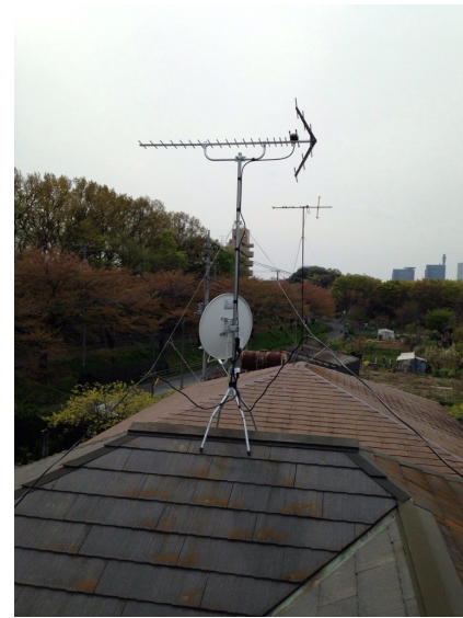
さいたま市浦和区三崎 地デジアンテナとBSアンテナ屋根上工事
