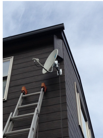
さいたま市浦和区瀬ヶ崎 ナビハウジング様物件 壁面取付 デザインアンテナとB Sアンテナ工事
