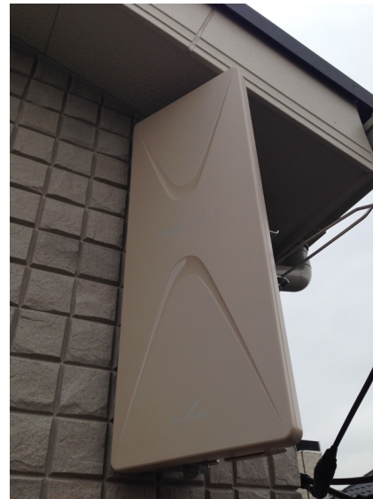
さいたま市浦和区木崎 住友不動産様物件 壁面取付 デザインアンテナ工事
