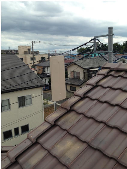
さいたま市浦和区瀬ヶ崎 ナビハウジング様物件 壁面取付 デザインアンテナ工事
