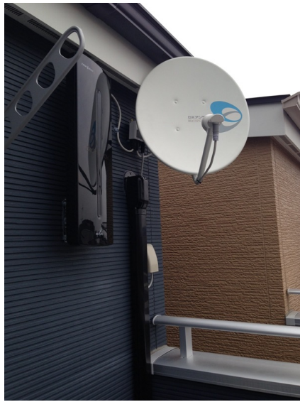
さいたま市浦和区上木崎 壁面取付 デザインアンテナとBSアンテナ工事
