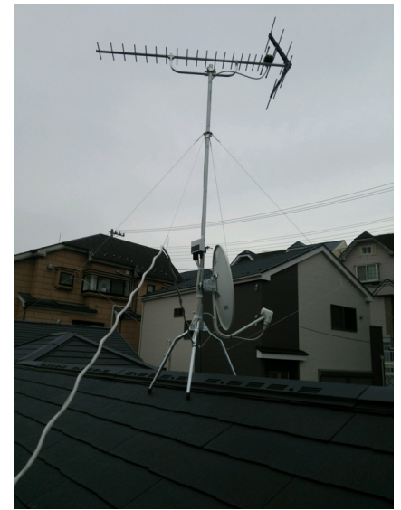
さいたま市桜区白鵜 地デジアンテナとBSアンテナ屋根上工事
