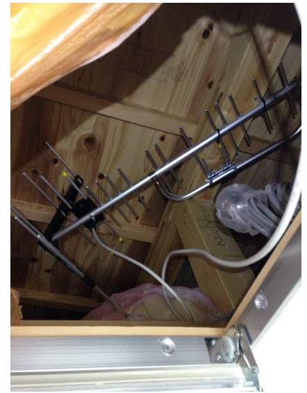
さいたま市桜区桜田 永大様物件 地デジアンテナ屋根裏工事
