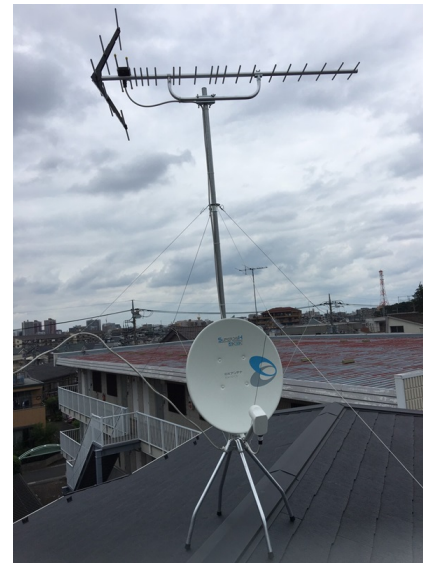
さいたま市桜区山久保 ナビハウジング様物件 地デジアンテナとBSアンテナ屋根上工事
