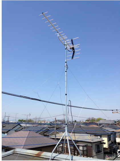
さいたま市西区佐知川 屋根上設置 八木式アンテナ工事
