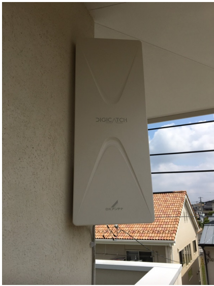
さいたま市緑区大門 山田ハウス様物件 壁面取付 デザインアンテナ工事
