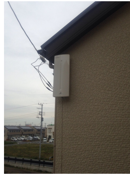
さいたま市緑区大門 タカラレーベン様物件 壁面取付 デザインアンテナ工事
