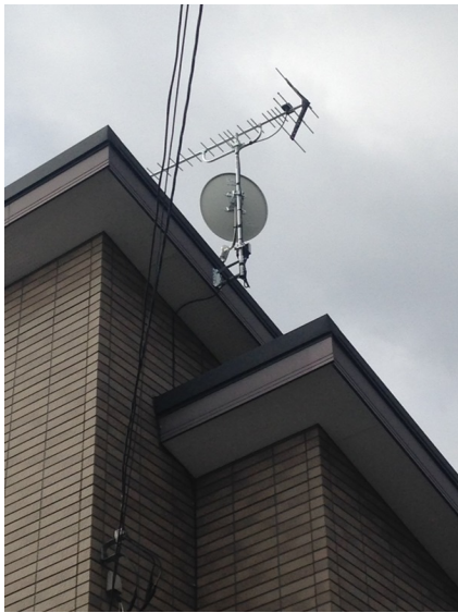
さいたま市緑区三室 壁面取付 地デジアンテナとBSアンテナ工事
