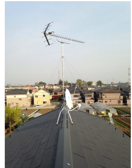
さいたま市緑区馬場 地デジアンテナとB S アンテナ屋根上工事
