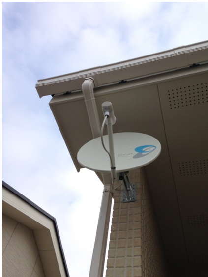
さいたま市岩槻区釣上新田 壁面取付 B S アンテナ工事
