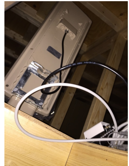
さいたま市岩槻区鹿室 東栄住宅様物件 デザインアンテナの屋根裏設置
