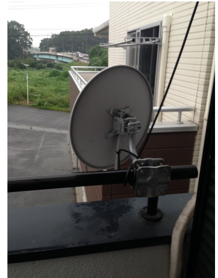
さいたま市岩槻区上野 ベランダ取付 BSアンテナ工事
