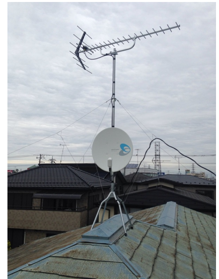
さいたま市岩槻区府内 地デジアンテナとBSアンテナ屋根上工事
