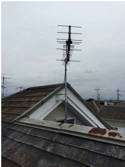
さいたま市岩槻区上野 一建設様物件 壁面取付 地デジアンテナ工事
