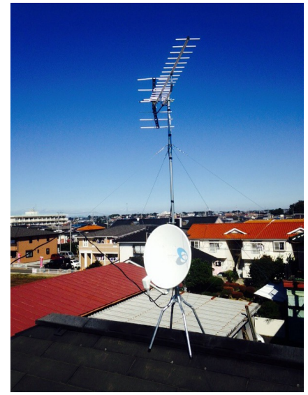
さいたま市岩槻区西原台 地デジアンテナとBSアンテナ屋根上工事
