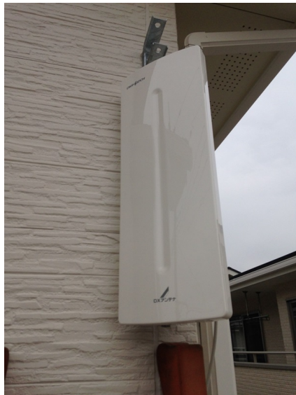
さいたま市岩槻区釣上新田 松永住宅様物件 壁面取付 デザインアンテナ工事
