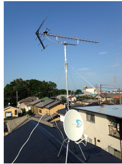
さいたま市岩槻区城町 地デジアンテナとBSアンテナ屋根上工事
