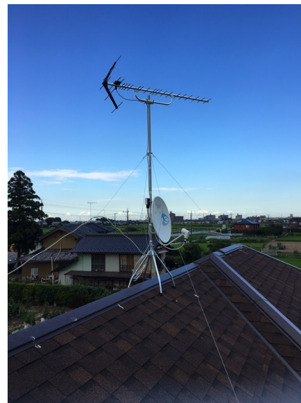
久喜市上内 飯田産業様物件 地デジアンテナとBSアンテナ屋根上工事
