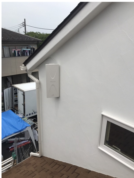
久喜市菖蒲町 アットナチュレ様物件 壁面取付 デザインアンテナ工事
