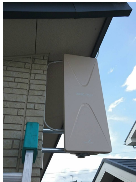
久喜市栗橋東 アキュラホーム様物件 壁面取付 デザインアンテナ工事
