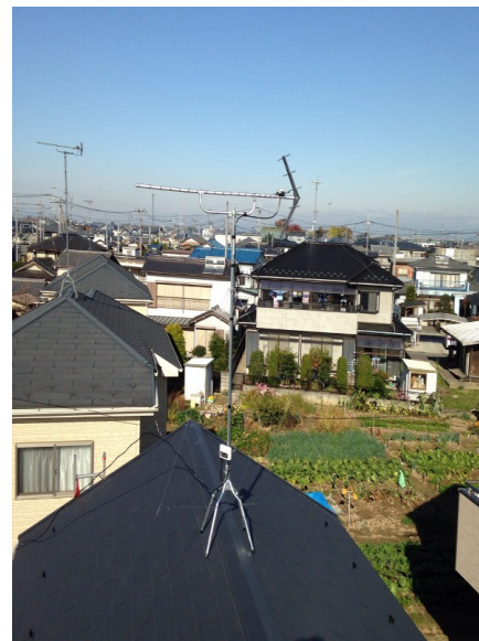
久喜市伊坂 地デジアンテナ屋根上工事
