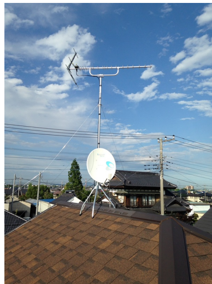
久喜市吉羽 タクトホーム様物件 地デジアンテナとB S アンテナ屋根上工事
