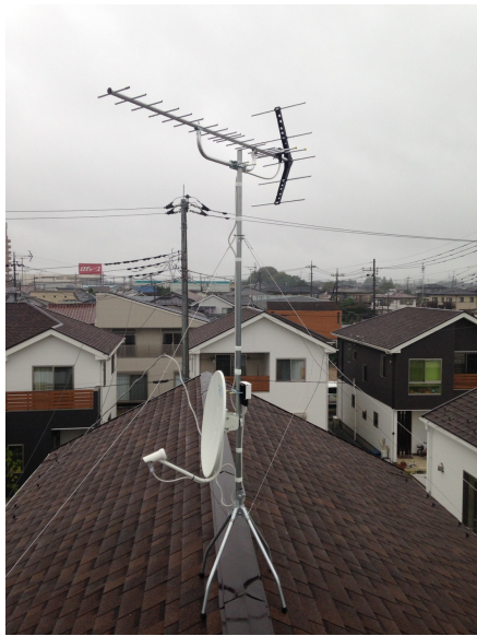
久喜市久喜北 ケイアイスター様物件 地デジアンテナとBSアンテナ屋根上工事
