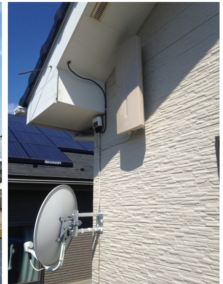
久喜市八浦 クライムホーム様物件 壁面取付 デザインアンテナとBSアンテナ工事
