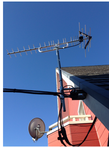
久喜市所久喜 破風板取付 八木式アンテナ工事 (既存BSアンテナあり)
