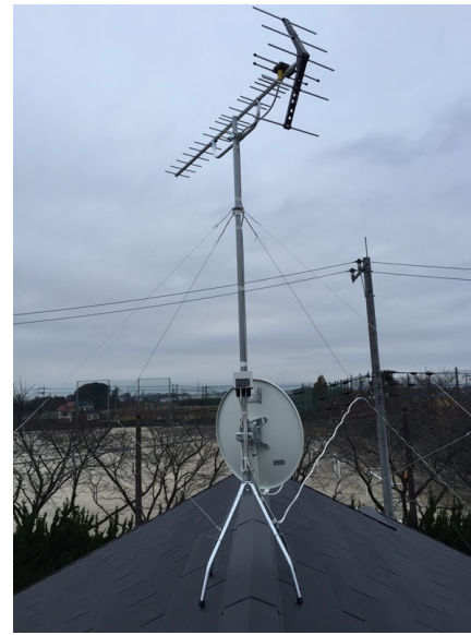
久喜市伊坂 K nホーム様物件 地デジアンテナとB S アンテナ屋根上工事
