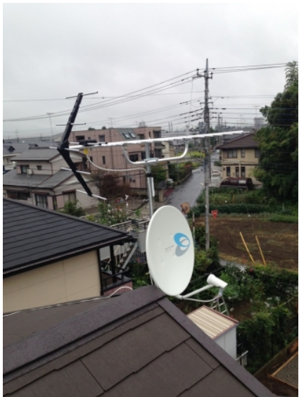
鴻巣市登戸 スウェーデンハウス様物件 壁面取付 地デジアンテナとBSアンテナ工事
