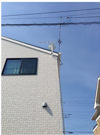
鴻巣市氷川町 八木式アンテナとBS/CSアンテナ工事後の外観
