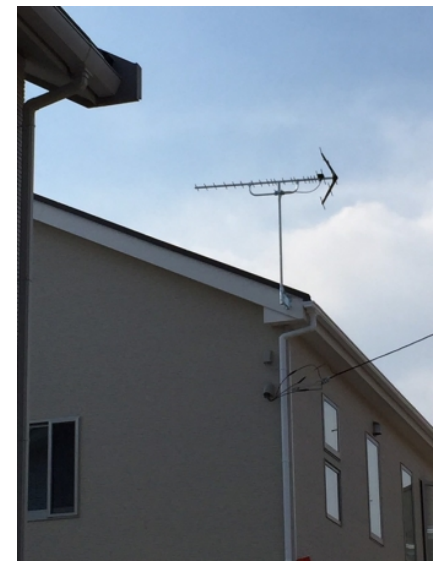
鴻巣市逆川 ケイアイスター不動産様物件 壁面取付 地デジアンテナ工事
