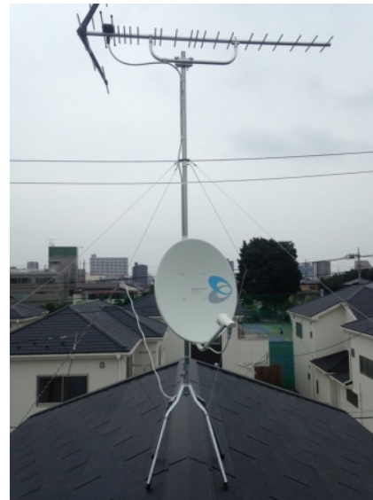
鴻巣市大間 一建設様物件 地デジアンテナとBSアンテナ屋根上工事
