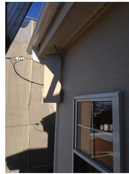
鴻巣市屈巢 コガネイハウジング様ご物件 壁面取付 デザインアンテナ工事
