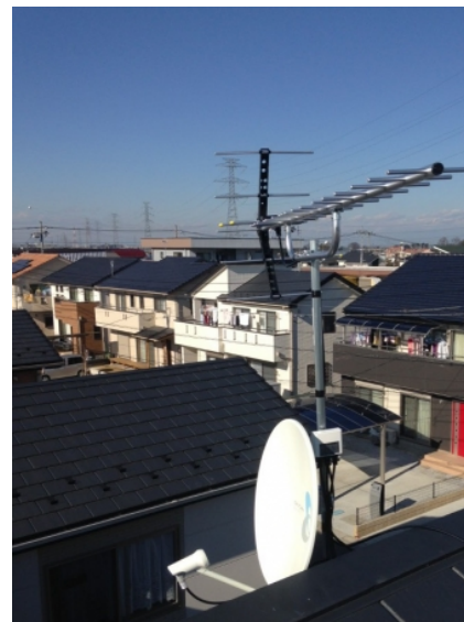
鴻巣市鴻巣 東進地所様物件 壁面取付 地デジアンテナとBSアンテナ工事
