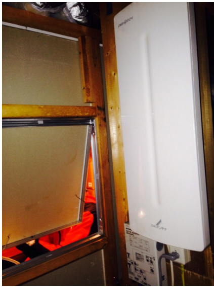
越谷市袋山 デザインアンテナ屋根裏工事
