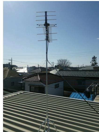
越谷市赤山町 地デジアンテナ屋根上工事
