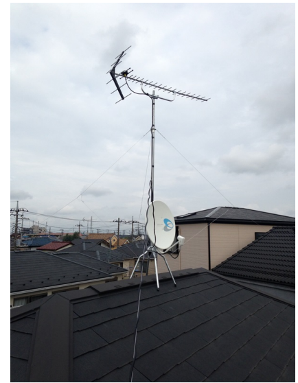
越谷市袋山 地デジアンテナとBSアンテナ屋根上工事
