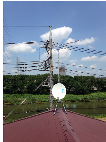
越谷市神明町 地デジアンテナとBSアンテナ屋根上工事
