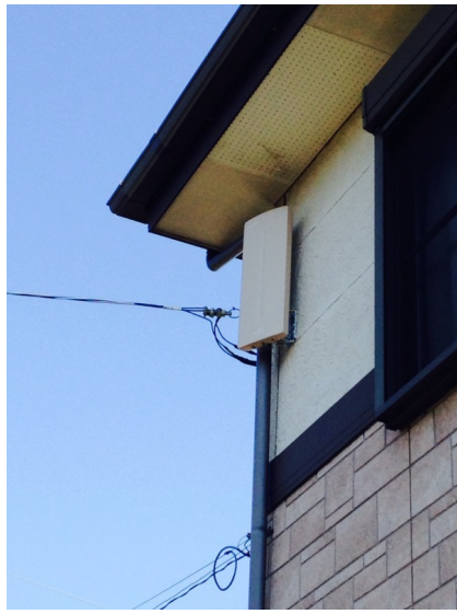
越谷市北後谷 壁面取付 デザインアンテナ工事
