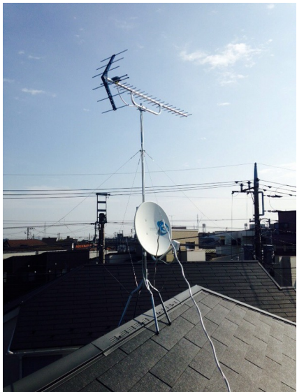
越谷市袋山 地デジアンテナとBSアンテナ屋根上工事
