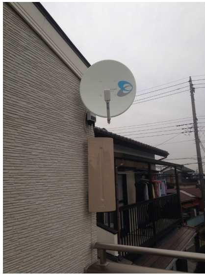
越谷市瓦曽根 壁面取付 地デジアンテナ工事
