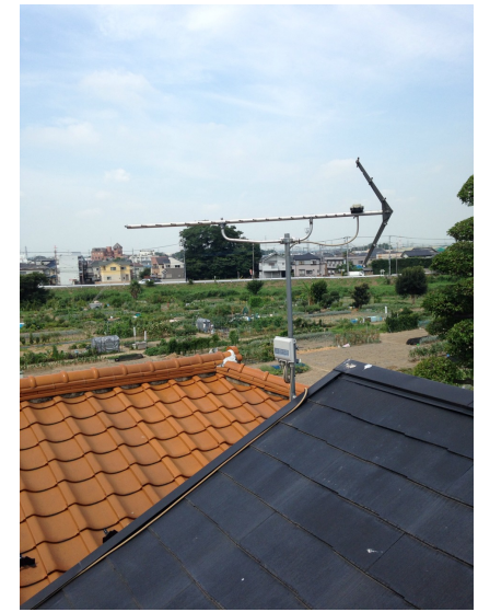
越谷市大房 壁面取付 地デジアンテナ工事
