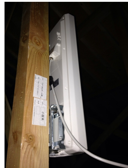
越谷市レイクタウン ミサワホーム様物件 屋根裏工事 デザインアンテナ工事
