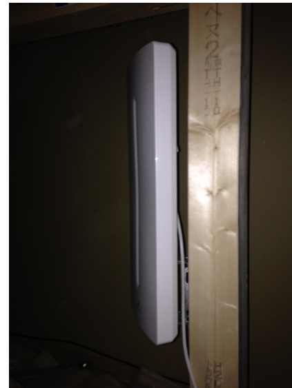
越谷市宮前 永大様物件 デザインアンテナ屋根裏工事
