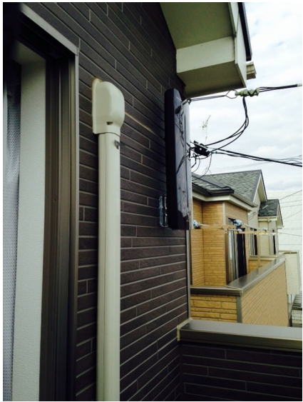
越谷市大里 飯田産業様物件 壁面取付 デザインアンテナ工事
