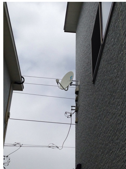
越谷市レイクタウン ミサワホーム様物件 壁面取付 BSアンテナ工事
