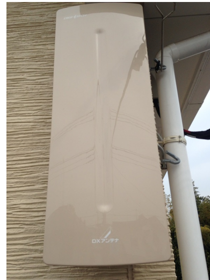
北本市東間 スカイホーム様物件 壁面取付 デザインアンテナ工事
