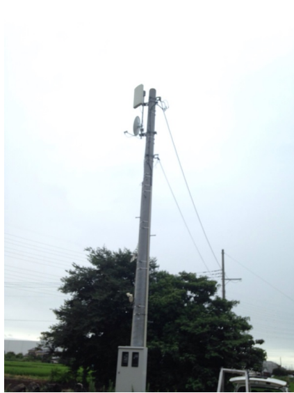
北本市深井 デザインアンテナとBSアンテナ工事後の外観
