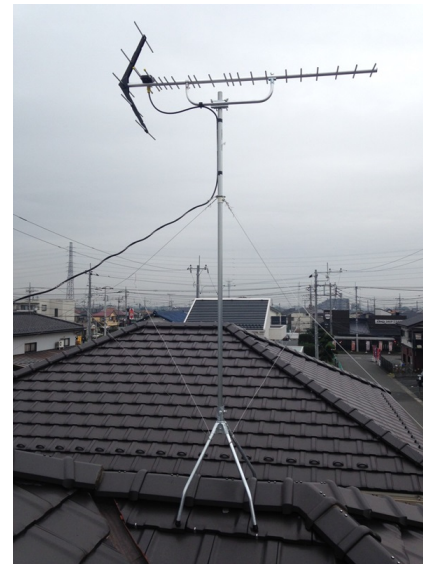
北本市東間 三国ホーム様物件 地デジアンテナ屋根上工事
