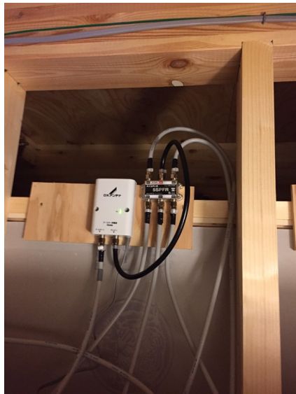
北本市中丸 ファイブイズホーム様物件 ブースター電源部 5分配器
