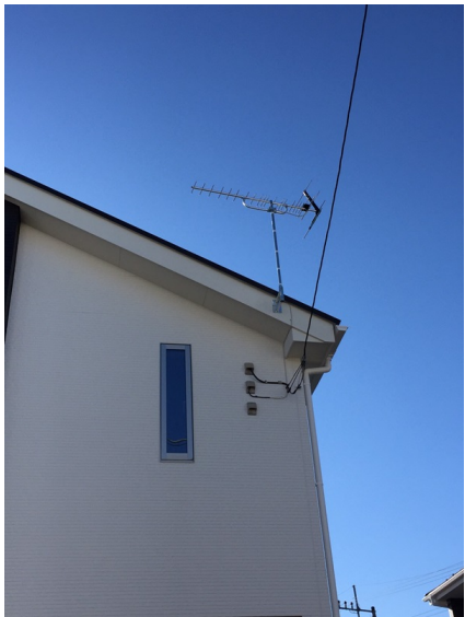
北本市中丸 壁面取付 地デジアンテナ工事
