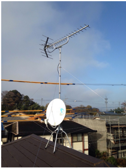
北本市下石戸下 地デジアンテナとBSアンテナ屋根上工事
