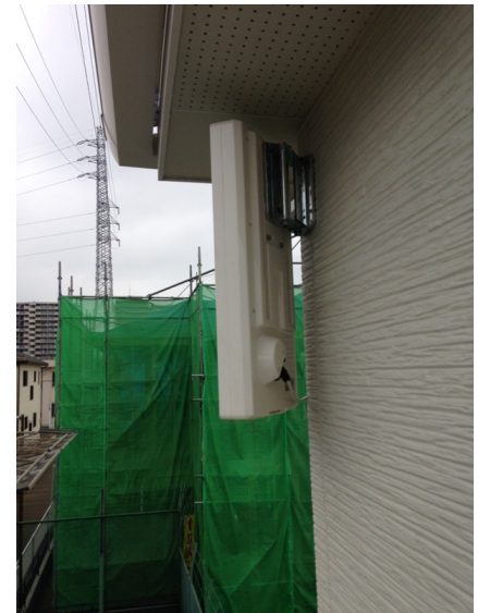
北本市東町 山岸工業様物件 壁面取付 デザインアンテナ工事
