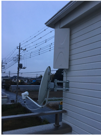
加須市久下 コガネイハウジング様物件 壁面取付 デザインアンテナとBSアンテナ工事
