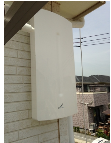
加須市多門寺 壁面取付 デザインアンテナ工事
