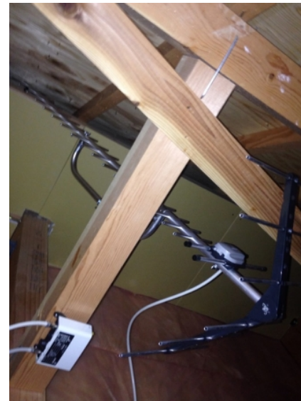
加須市南篠崎 ケイアイスター不動産様物件 地デジアンテナ屋根裏工事
