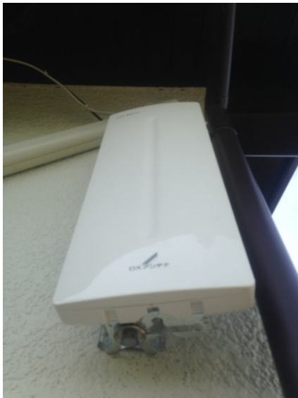
加須市鴻茱 壁面取付 デザインアンテナ工事
