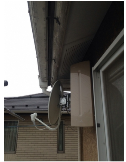
加須市花崎北 壁面取付 デザインアンテナとBSアンテナ工事
