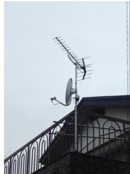
加須市東栄 野本建設様物件 地デジアンテナとBSアンテナ工事
