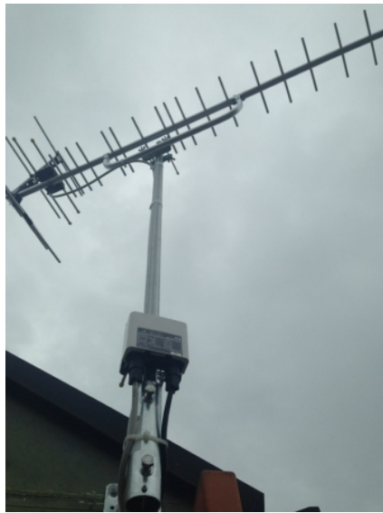
加須市礼羽 壁面取付 地デジアンテナ工事
