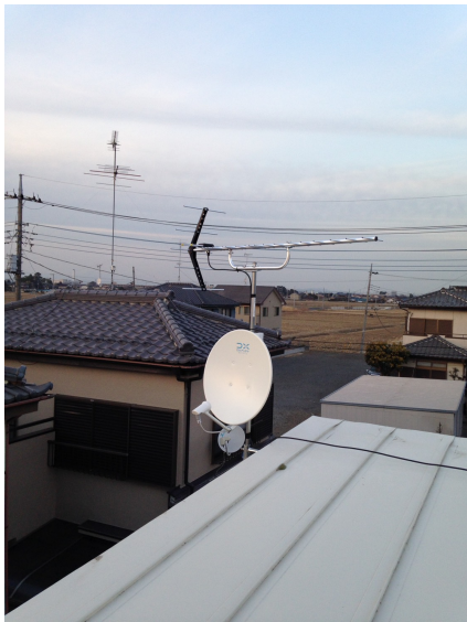
加須市根古屋 一条工務店様ご物件 破風板取付 八木式アンテナとBS/CSアンテナ 工事
