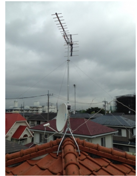
加須市花崎北 地デジアンテナとBSアンテナ屋根上工事
