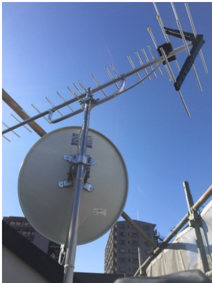
加須市花園北 カクダイホーム様物件 壁面取付 地デジアンテナとBSアンテナ工事
