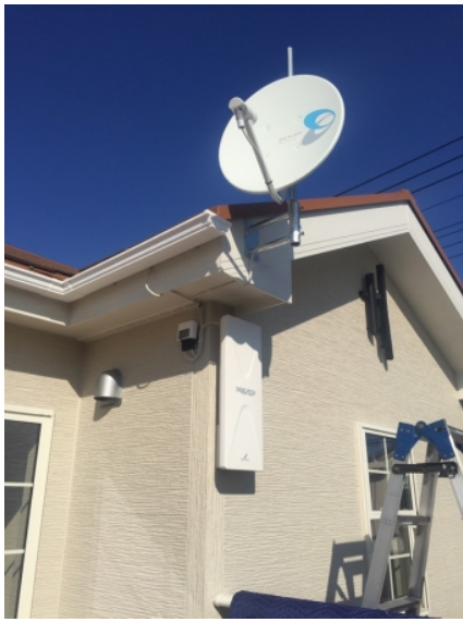
北足立郡伊奈町小室 STKホーム様物件 壁面取付 デザインアンテナとBSアンテナ工事
