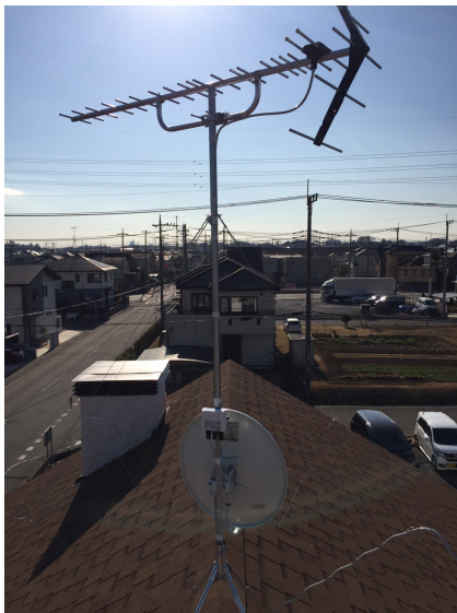
北足立郡伊奈町西小針 屋根上設置 八木式アンテナとBS/CSアンテナ工事
