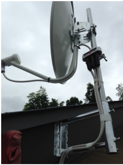
北足立郡伊奈町大針 壁面取付 BSアンテナ工事
