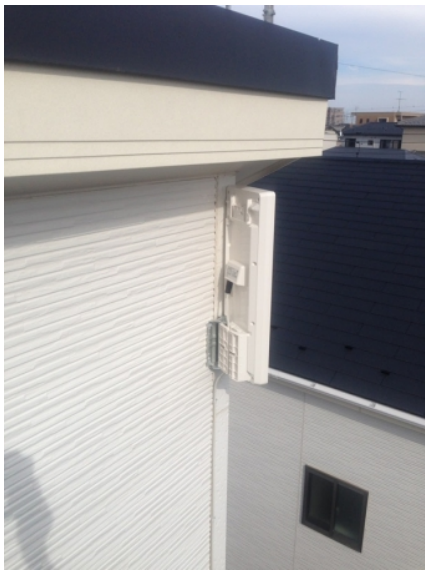
北足立郡伊奈町大針 東栄住宅様物件 壁面取付 デザインアンテナ工事
