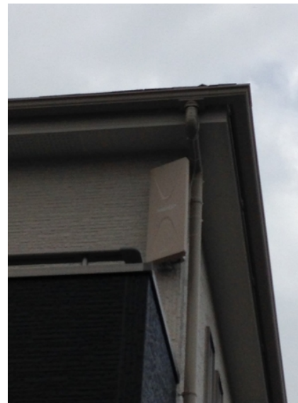
北足立郡伊奈町小室 三国ホーム様物件 壁面取付 デザインアンテナ工事
