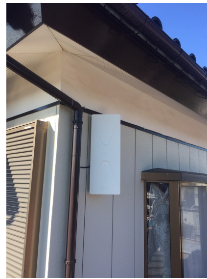
桶川市田谷 壁面取付 デザインアンテナ工事
