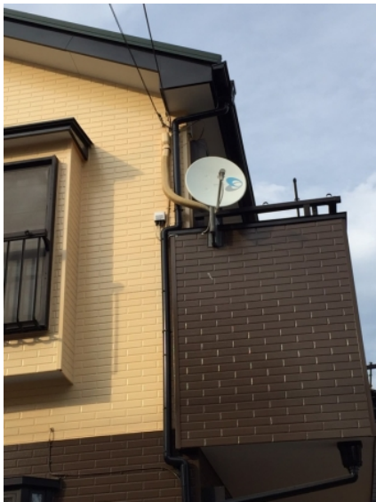
桶川市加納 壁面取付 BSアンテナ工事
