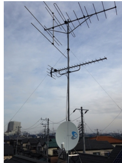
桶川市鴨川 地デジアンテナとBSアンテナ屋根上工事
