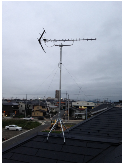
桶川市下日出谷 コガネイハウジング様物件 地デジアンテナ屋根上工事
