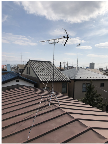
桶川市北 屋根上設置 八木式アンテナ工事
