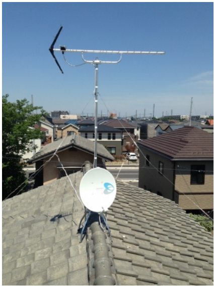
桶川市下日出谷 日本電建様物件 地デジアンテナとBSアンテナ屋根上工事
